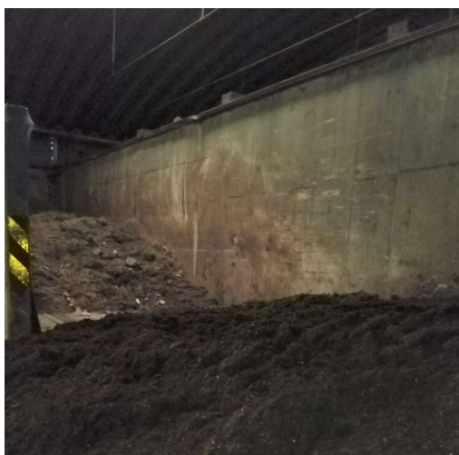
Figura 23 - Túneis de pré compostagem
