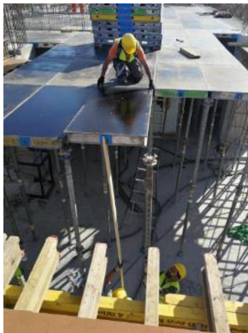
Figura 12 – Montagem dos painéis.
