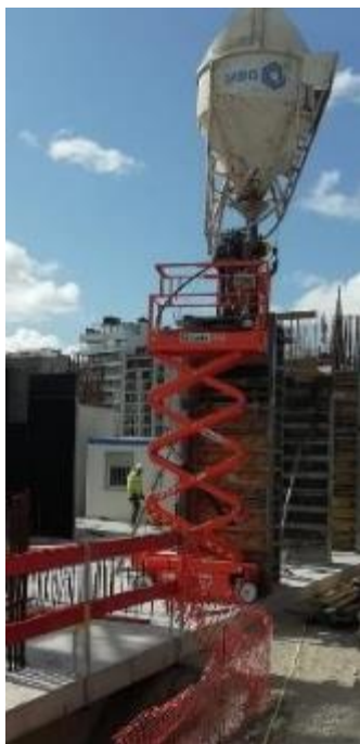
Figura 44 – Betonagem do pilar
