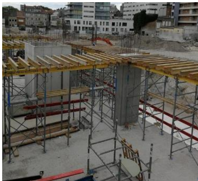
Figura 51 – Sistema Doka montada sobre as torres
