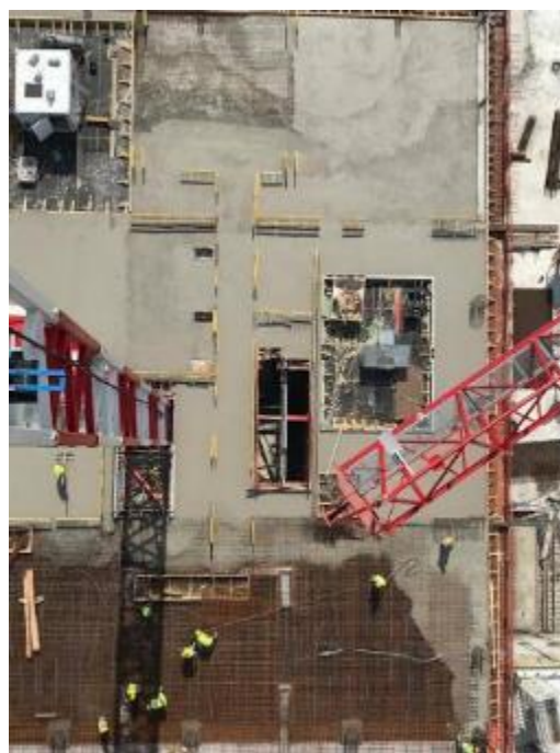
Figura 26 – Vista superior de laje parcialmente betonada
