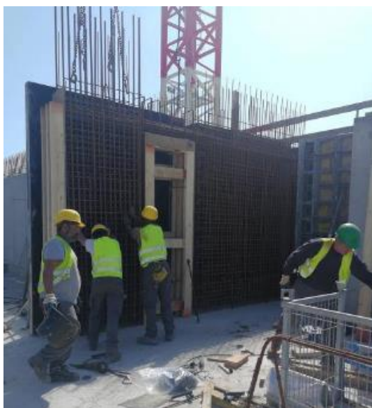
Figura 27 – Armadura sendo colocada por trabalhadores
