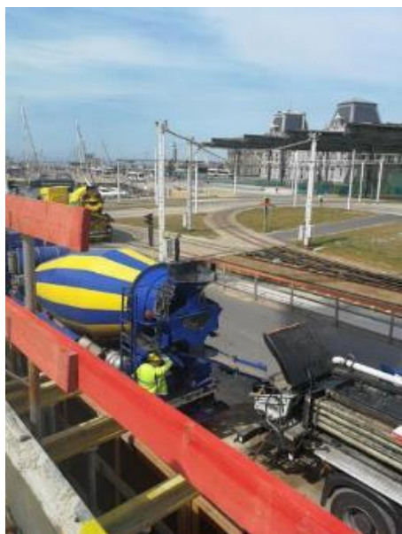
Figura 21 – Camião de betão a abastecer camião bomba
