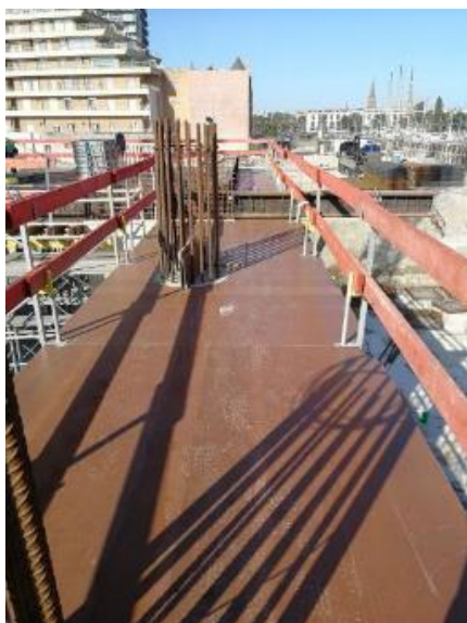
Figura 52 – Plataforma de trabalho e base da cofragem montado
