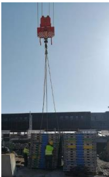
Figura 9 – Engate do TOPEC a grua torre.
