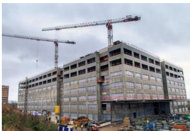
Figura 2 - Obra do Instituto Jules Bordet executada pela CNT Bélgica. 6
