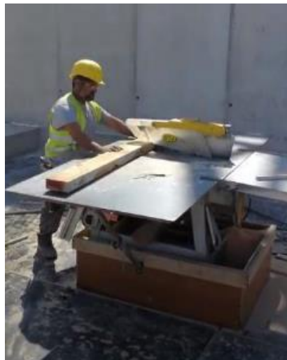
Figura 54 – Trabalhador utilizando serra elétrica
