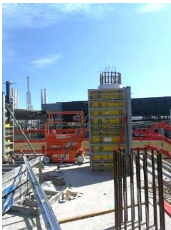
Figura 43 – Cofragem para reforço e estabilidade dos pilares colocadas
