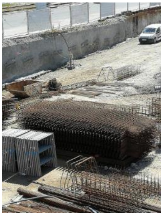
Figura 15 – Armação da laje no estaleiro de obra.
