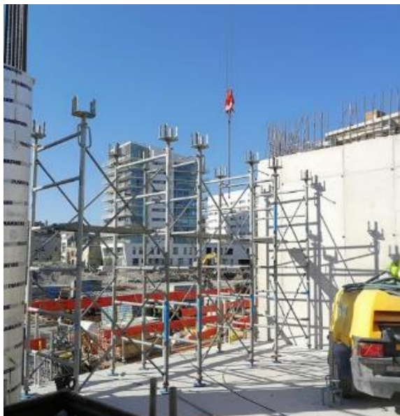
Figura 49 – Torres com montagem finalizada
