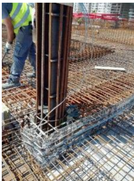
Figura 46 – Viga posicionada e ligada a laje e pilar
