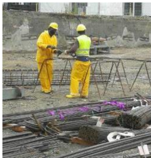
Figura 39 – Trabalhadores a montar os pilares no estaleiro de obra
