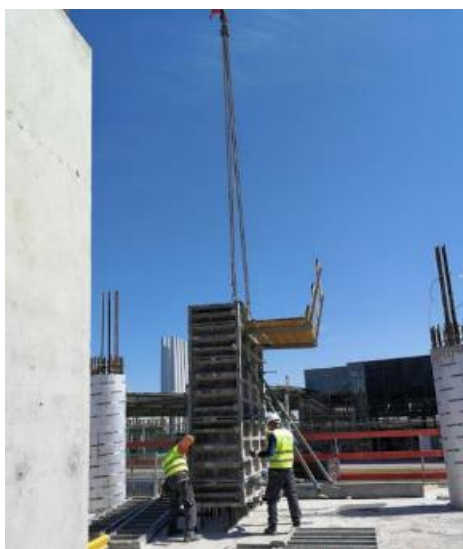
Figura 32 – Colocação de painéis previamente montados
