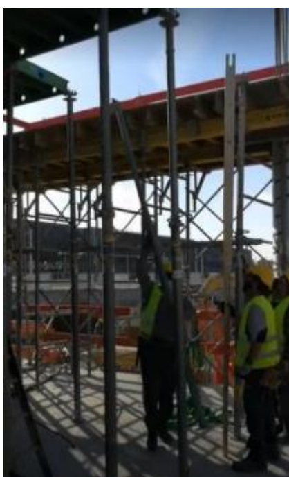
Figura 13 – Trabalhadores a espera do painel para engate das escoras.
