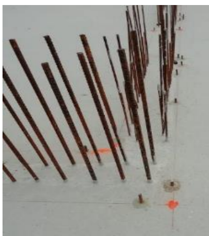
Figura 29 – Marcação dos muros pelo topógrafo
