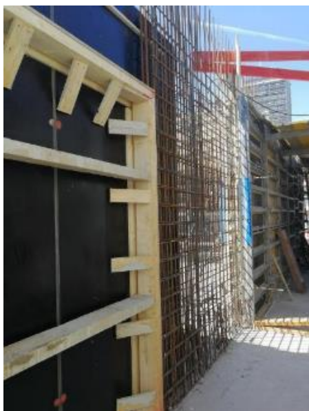
Figura 30 – Cofragem de espaços que não devem ser betonados no muro
