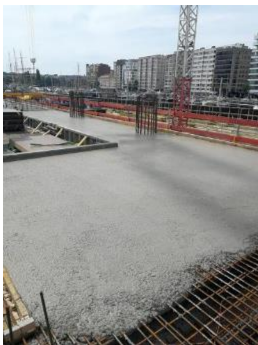
Figura 25 – Parte da laje betonada
