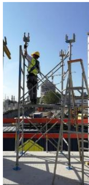
Figura 48 – Montagem das peças metálicas em formato de “U”
