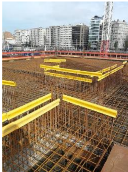
Figura 20 – Armação da laje finalizada.
