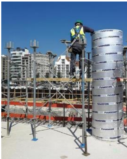
Figura 47 – Montagem das torres
