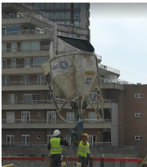
Figura 36 – Betonagem dos muros com auxílio do balde para descarga de betão
