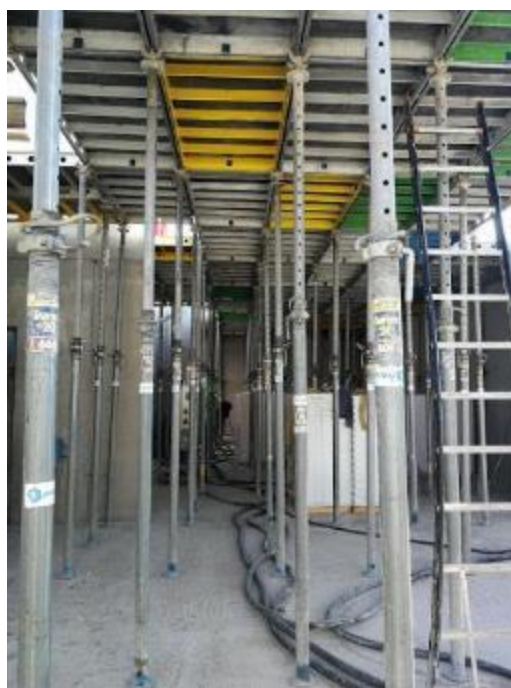
Figura 14 – Vista inferior da cofragem da laje montada.
