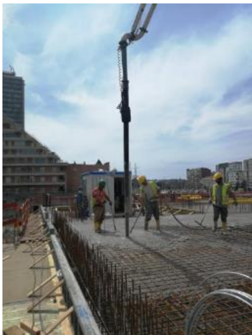
Figura 23 – Betão sendo bombeado para laje e trabalhador com vibrador
