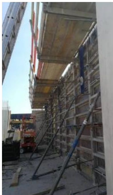
Figura 35 – Cofragem de muros com plataforma de trabalho
