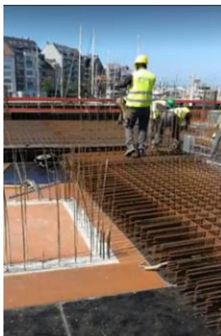
Figura 18 – Montagem da laje.
