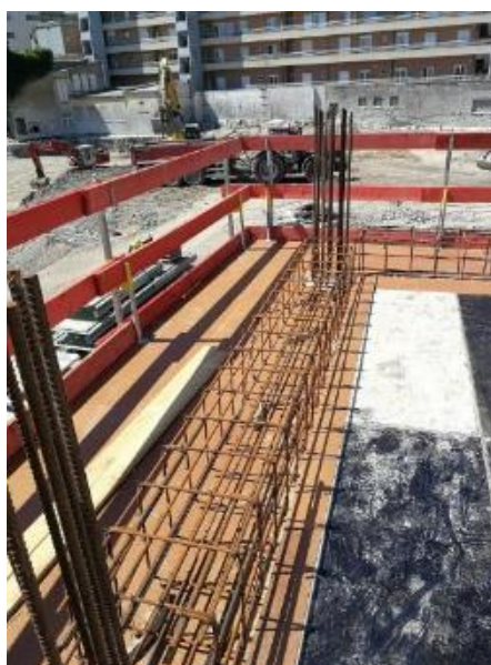
Figura 55 – Armação da viga posicionada
