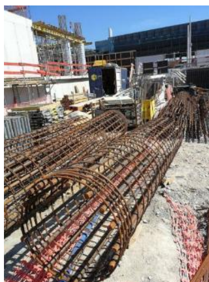
Figura 41 – Pilares pré-fabricados no estaleiro de obra
