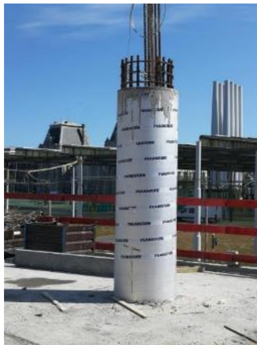
Figura 45 – Pilar após a betonagem
