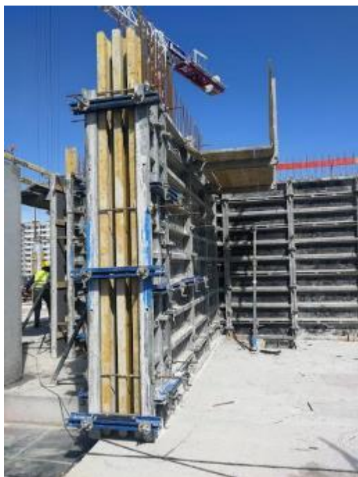
Figura 34 – Vista frontal da cofragem de muros
