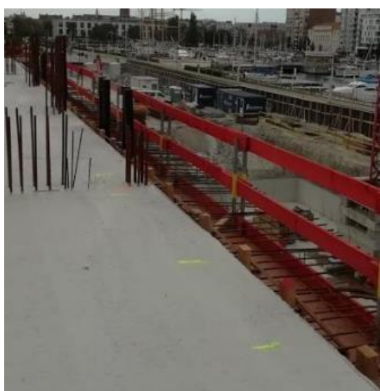
Figura 40 – Marcação na laje realizada pelo topógrafo
