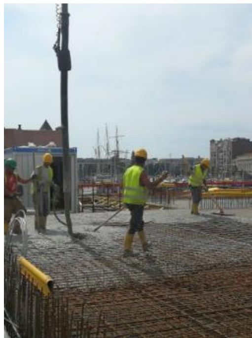
Figura 24 – Betão sendo bombeado para laje e trabalhador espalhando o material
