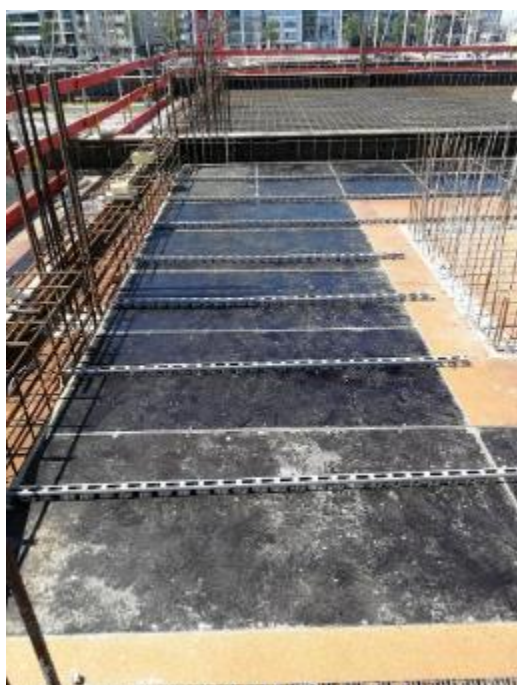
Figura 17 – Colocação dos espaçadores.
