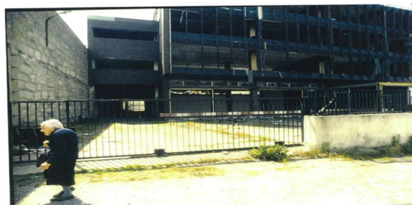
Figura 3: Pavilhões da Fábrica Alumínia, perto do bairro Pinheiro Torres, no início dos anos 90. Fonte: Imagem retirada da monografia do primeiro etnógrafo (Fernandes, 1997).
