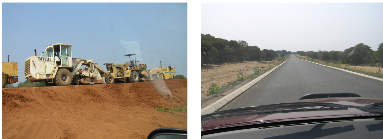
Figura 5.5: Aspecto da estrada EN-206 durante e após a construção.
