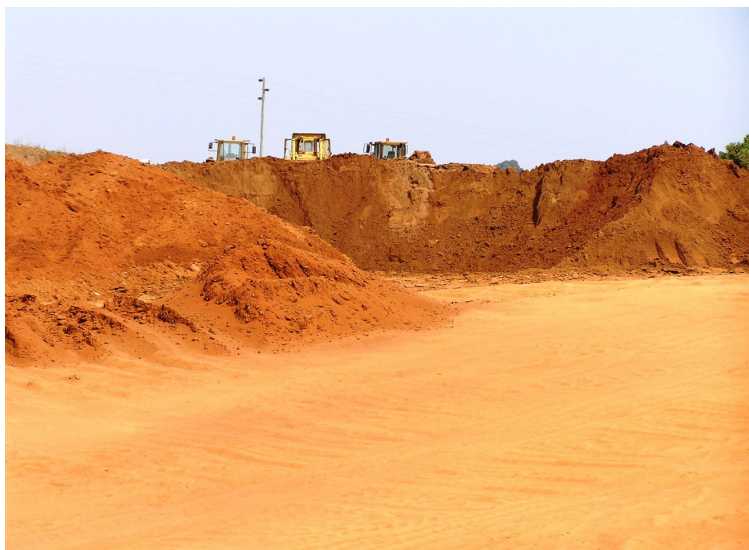
Figura 1.1: Uma das câmaras de empréstimo utilizada na construção da EN 206.
