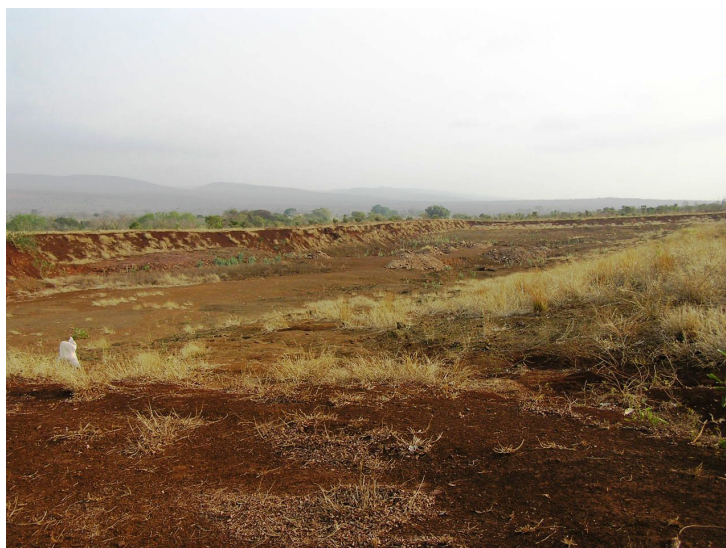
Figura 1.2: Outra das câmaras de empréstimo, neste caso para a construção da EN-MG.
