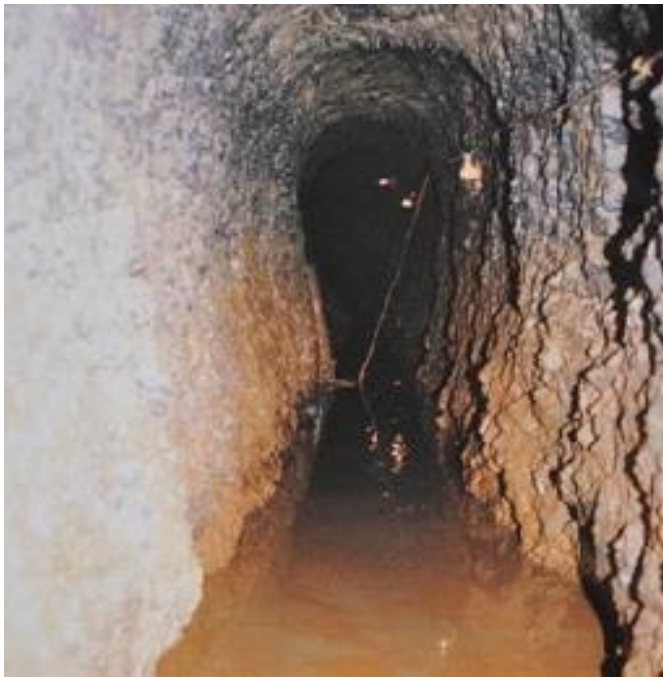
Figura 29 - Interior de uma Galeria de drenagem
