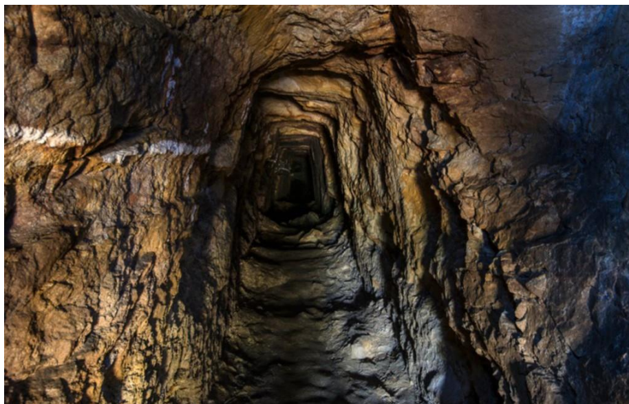
Figura 25 - Vista do interior de uma Galeria
