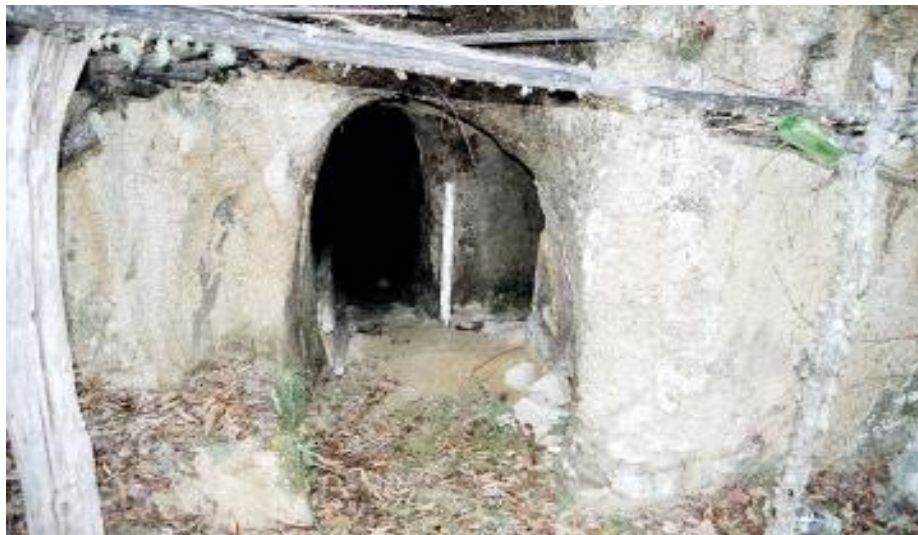
Figura 21 - Entrada de uma Galeria
