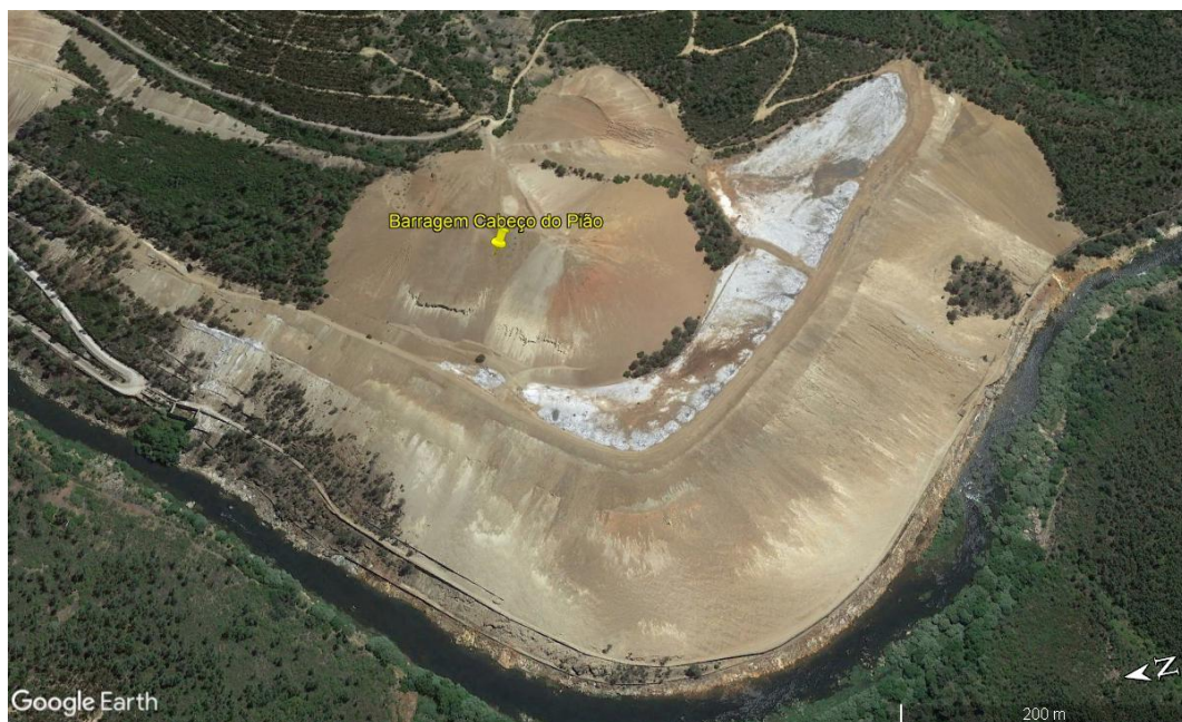
Figura 31. Barragem de rejeitados Cabeço do Pião (Google Earth Pro, 2020).
