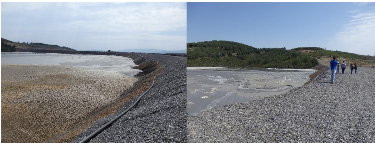
Figura 26. Barragem nova de rejeitados da lavaria Barroca Grande (Da autora, 2017).
