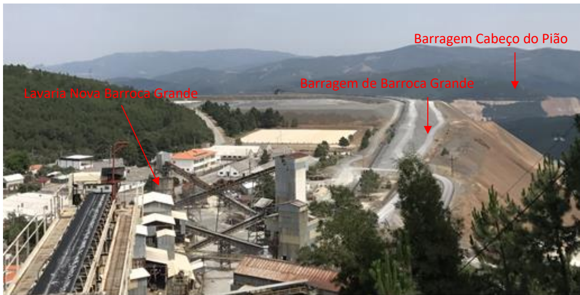
Figura 24. Instalações da lavaria e barragem de Barroca Grande, ao fundo barragem Cabeço do Pião (Da autora, 2017).
