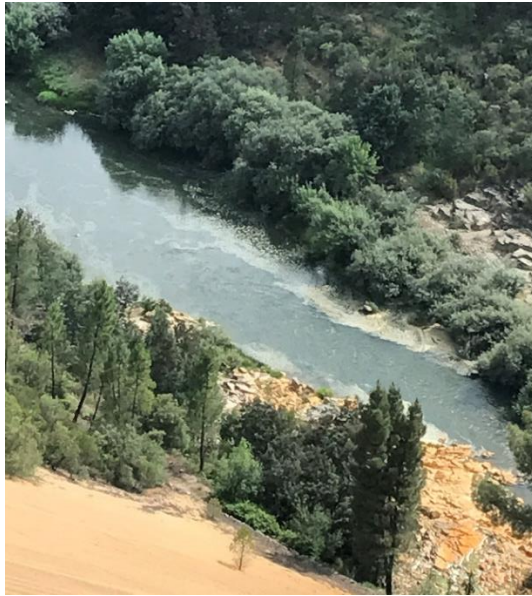
Figura 33. Vegetação pinheiro bravo crescendo nos taludes e na base da barragem (Da autora, 2017).
