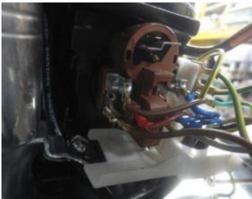
Figura 22. Ligação dos componentes elétricos ao compressor [7].
