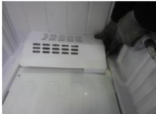
Figura 20. Proteção da placa evaporadora [7].
