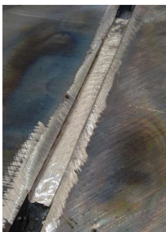
Figura 13 - Remoção de material antes do processo de temper bead
