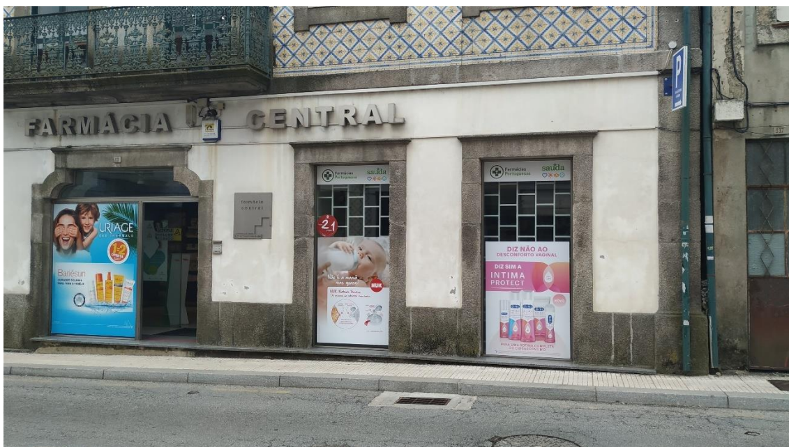
Anexo I - Fachada principal da Farmácia Central de Valbom antes da intervenção
