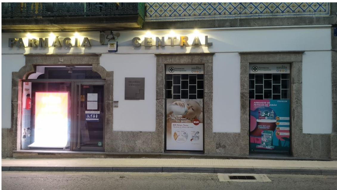
Anexo II - Fachada principal da Farmácia Central de Valbom após intervenção
