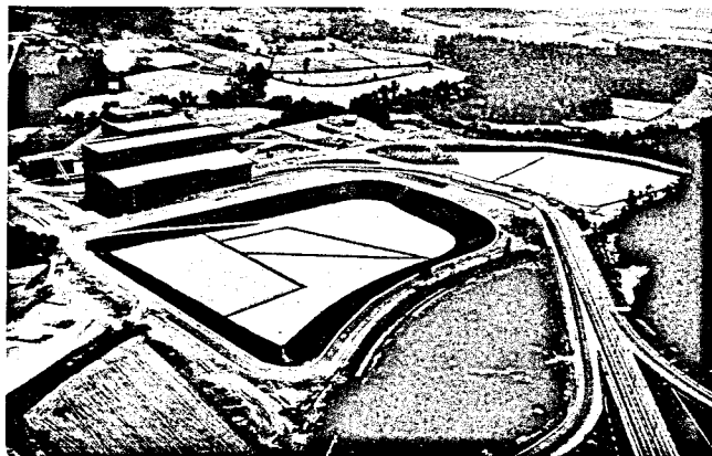
Figura 1. 18 – Exemplo da função de barreira de fluidos com geossintéticos.
