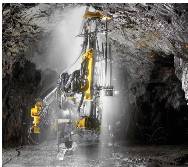
Figura 83 – Exemplo de furação vertical ascendente para posterior aplicação de pregagem do tipo Swellex (Epiroc, 2019).
