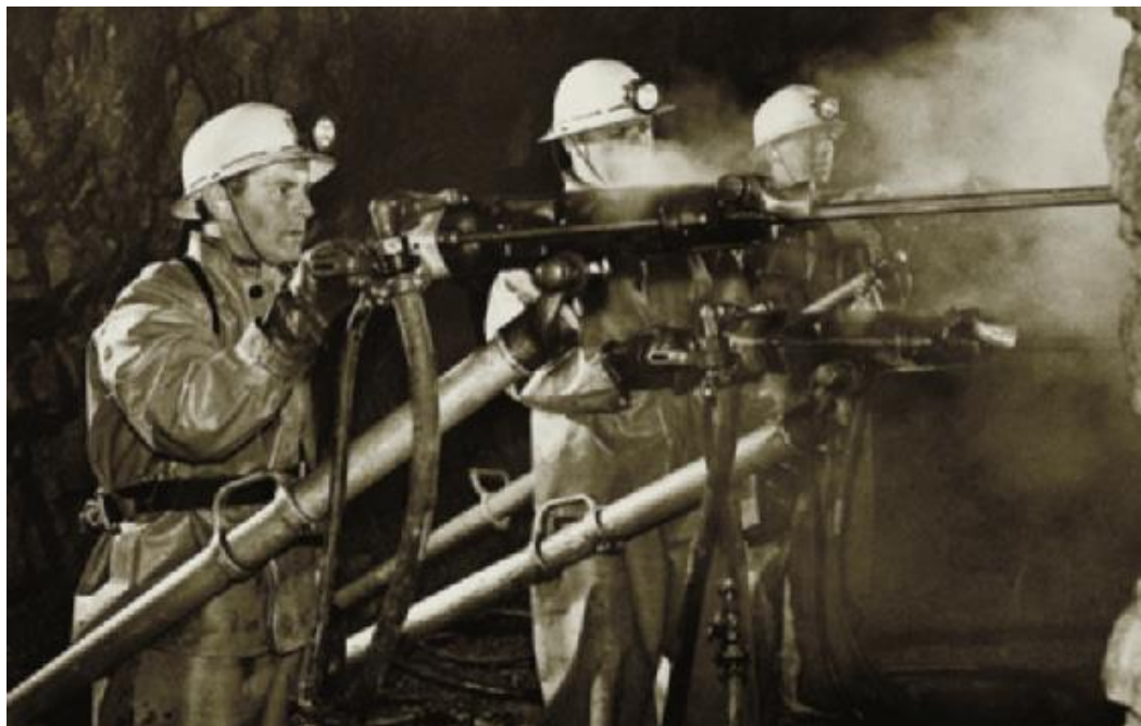
Figura 12 – Perfuração de rocha com recurso a um martelo e coluna pneumática, utilizando barrenas integrais (Atlas Copco, 2014).
