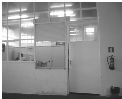
Figura 15 – Entrada do armazém de peças
