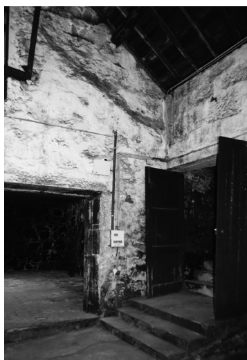
Fig.77 Paredes de meação entre os armazéns F,G,H
