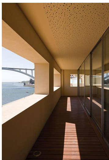
Fig.22 Vãos abertos na fachada Sul, com recuo dos caixilhos dos apartamentos, Douro's Place, Carlos Prata, Porto
