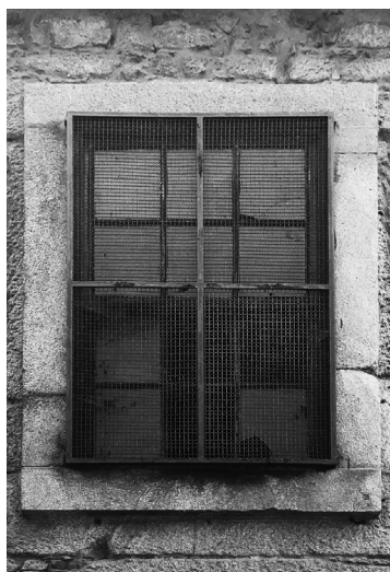
Fig.86 Janela de peito de guilhotina, lado exterior, armazém G
