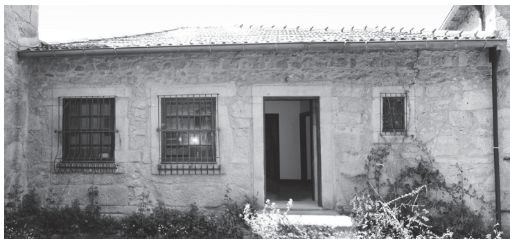
Fig.64 Vista do alçado sul do armazém H
