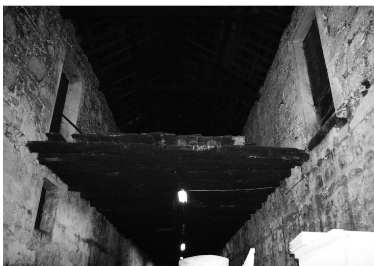
Fig.79 Vigamento dos sobrados apoiados nas paredes de fachado, armazém G
