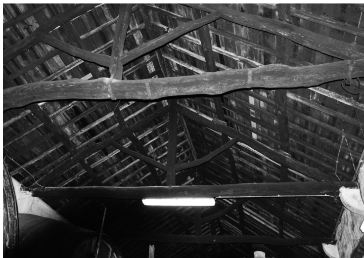
Fig.84 Estrutura de cobertura de asna de pendural, armazém F
