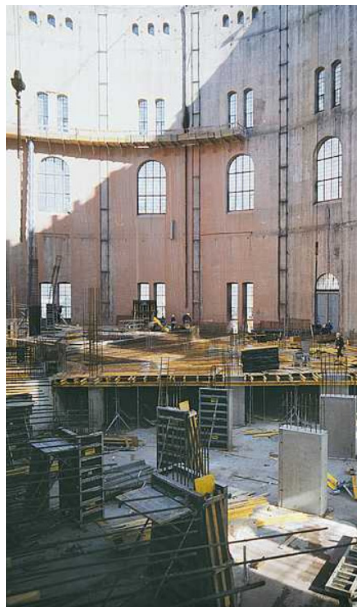
Fig.31 Fase de construção no interior de um gasômetro, nova construção em pilares de betão, Viena
