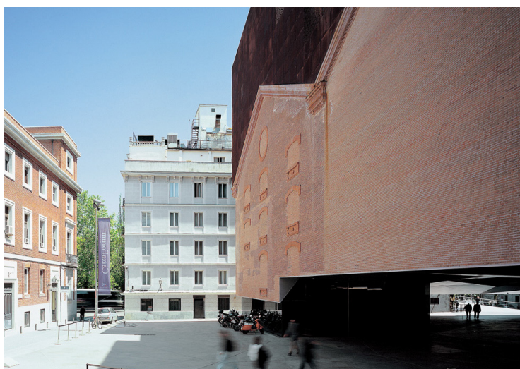
Fig.28 Praça coberta após demolição do embasamento, CaixaForum Madrid, Herzog & de Meuron, Madrid
