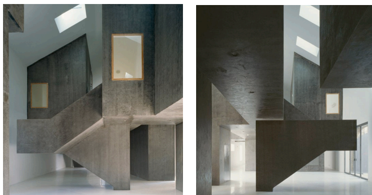
Fig.114 Novo corpo em betão no interior do preexistente, Embaixada Arquitetura
