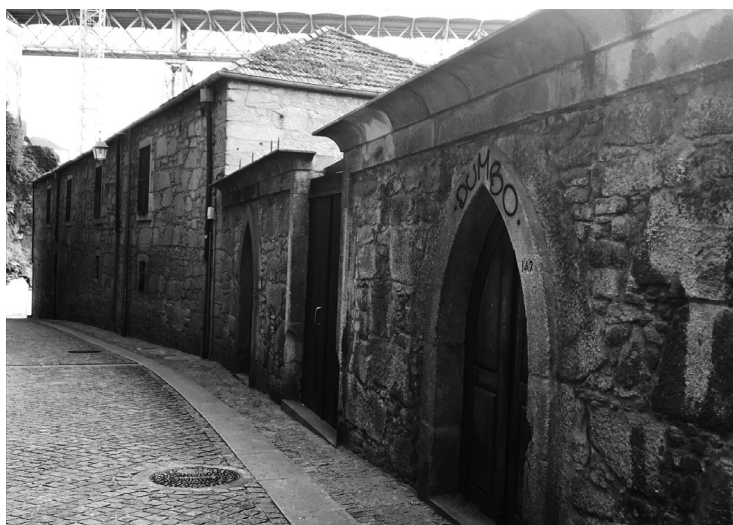
Fig.59 Vista do alçado sul, armazém G
