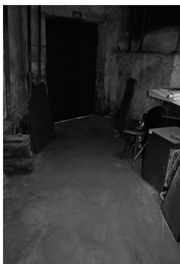
Fig.80 Piso térreo em argamassa de betonilha, armazém G
