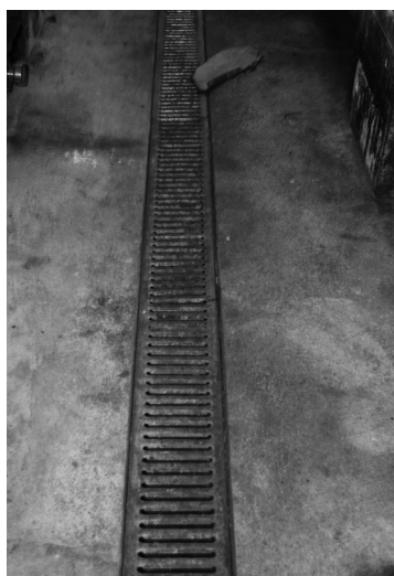
Fig.82 Piso térreo em argamassa de betonilha, armazém F
