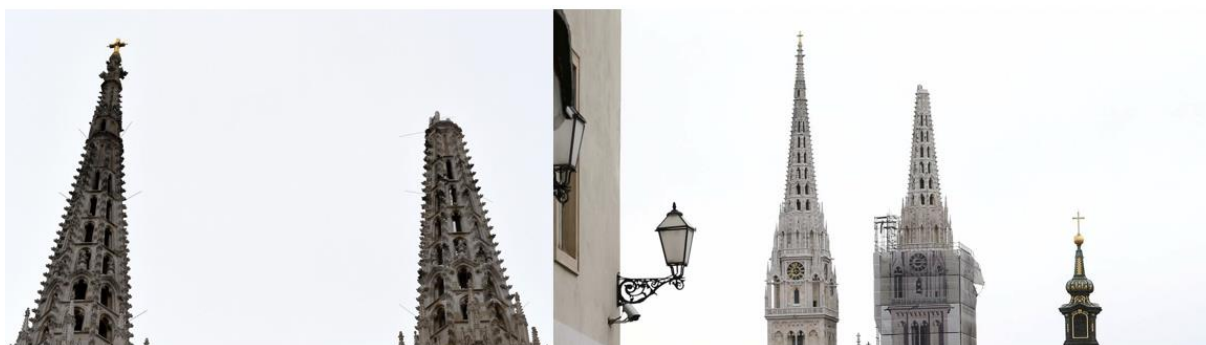
Fig. 1.3 – Colapso do pináculo da Catedral de Zagreb (www.sabado.pt; www.elnuevodia.com )
