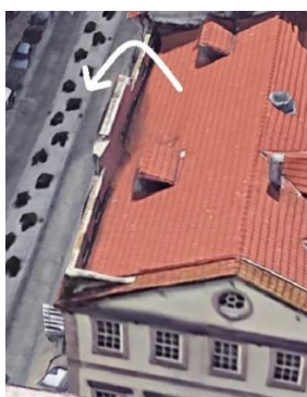
Fig. 4.7 – Elemento de platibanda (GoogleMaps, 2020)
