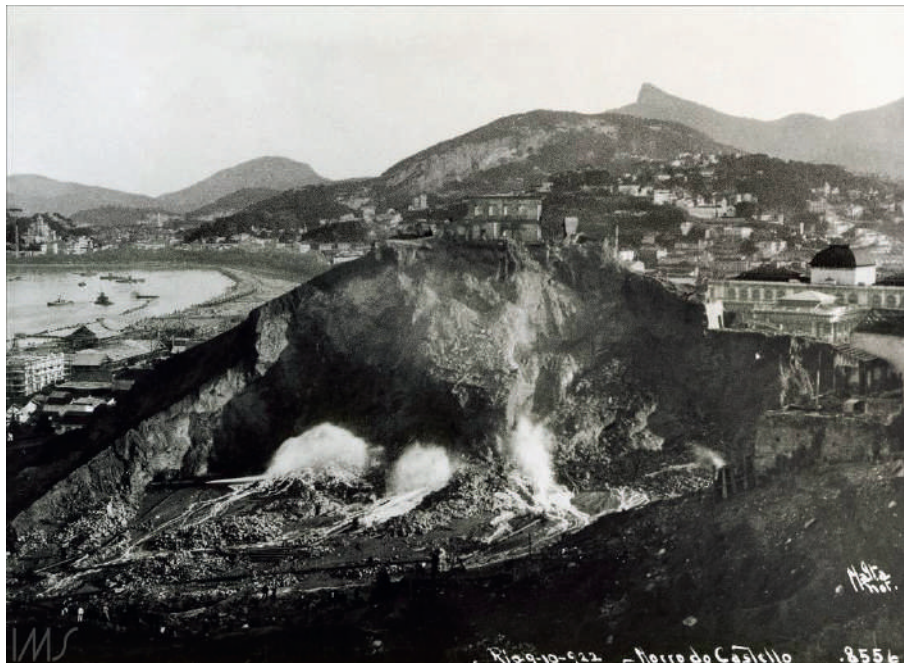
Figura 25. Augusto Malta - Desmonte do Morro do Castelo, 1922
