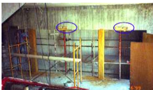
Fig. 4.27 - Sistema de pressão nas chapas metálicas de reforço coladas ao betão [45]
