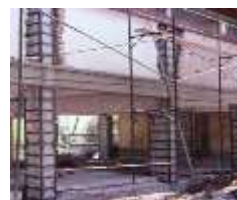
Fig. 4.5 - Perfil metálico no reforço de pilares [44]
