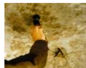
Fig. 2.9 – Medição do potencial de corrosão [18]
