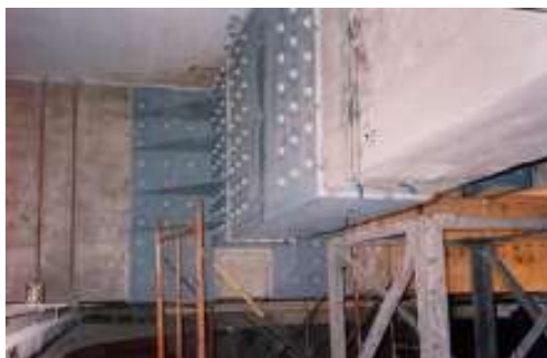
Fig. 4.33 - Reforço de uma viga com a introdução de perfis metálicos [45]
