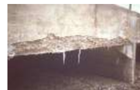
Fig. 2.38 - Fissuração devido ao ciclo de gelo/degelo [18]
