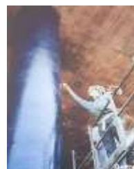
Fig. 4.29 - Mantas em um pilar circular para reforço por confinamento [45]
