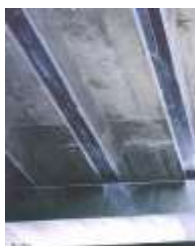
Fig. 4.28 - Laminados em vigas para reforço a flexão [45]
