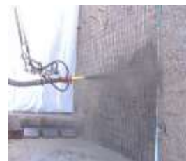
Fig. 4.14 - Aplicação do betão projetado [45]
