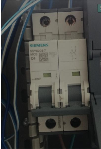
Figura B.2 - Disjuntor magneto-térmico.
