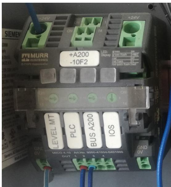
Figura B.3 - Distribuidor de corrente - MICO 4.10.
