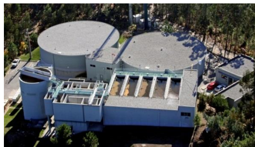
Figura 4 - ETA de Castelo de Paiva
