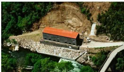
Figura 3 - Captação de Ponte da Bateira
