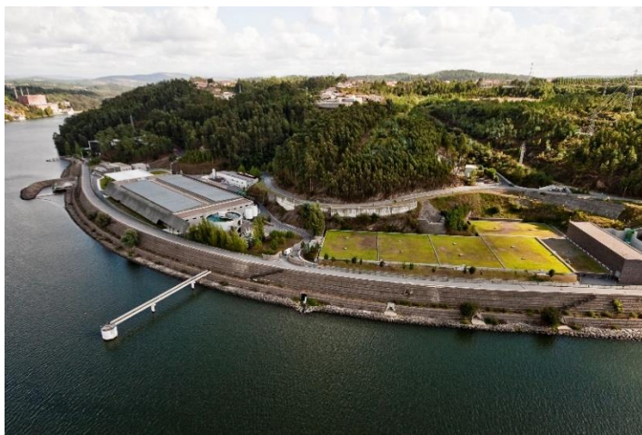
Figura 2 - Complexo da ETA de Lever
