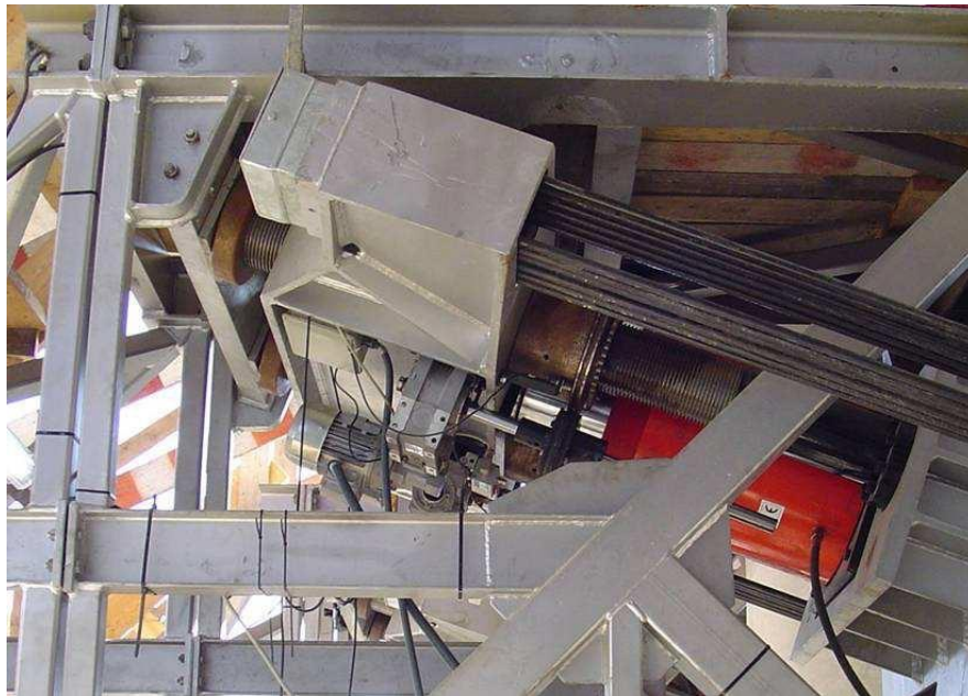
Fig. 2.7 Ancoragem ativa [10].
