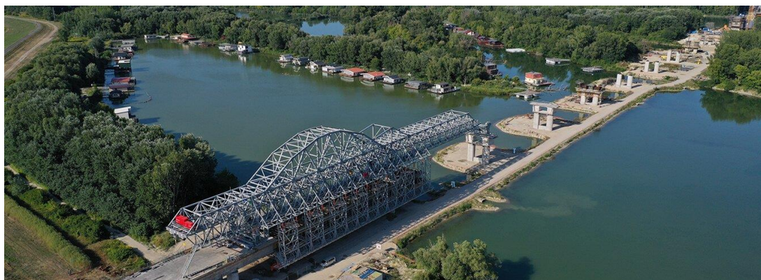
Fig. 2.18 - Cimbra autolanzável MSS M1-70-S – Construção do Viaduto Oeste [11].
