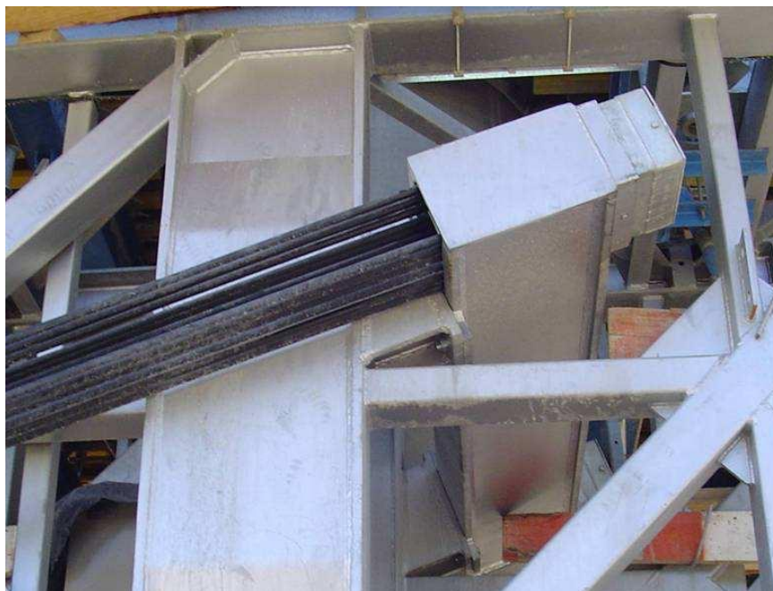
Fig. 2.8 Ancoragem passiva [10].
