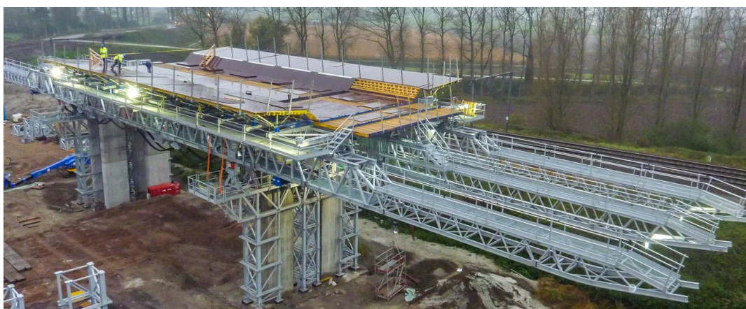
Fig. 2.3 – Cimbra autolançável inferior MSS M35-I (www.berd.eu).
