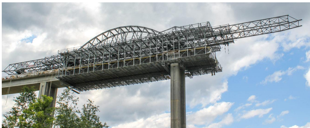
Fig. 2.2 - Cimbra autolançável MSS M45-S (www.berd.eu)
