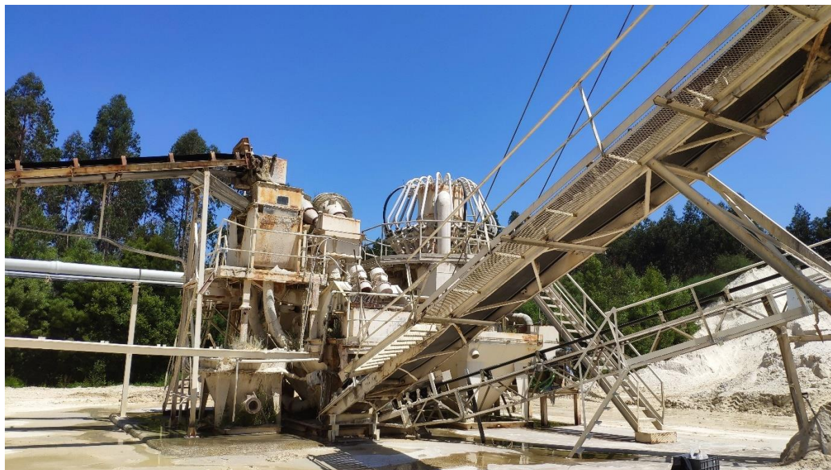
Figura 1 - Instalação de tratamento de caulinos em estudo
