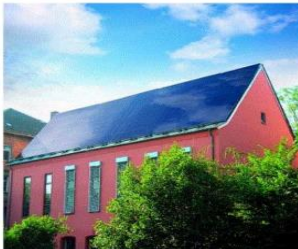
Figura 12 - Aplicação da tecnologia CIS no telhado de uma igreja (Torzewski, 2015).
