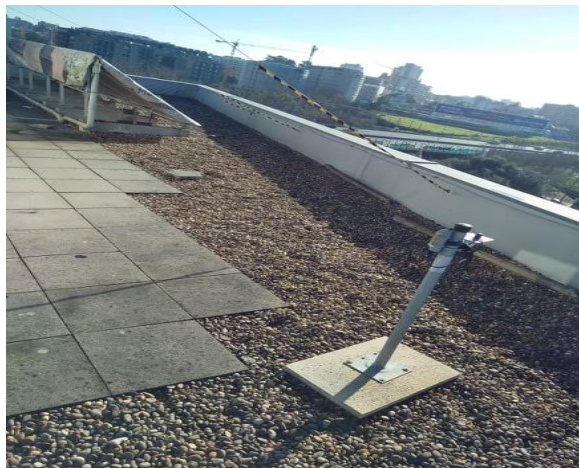
Figura 16 - Fotografia da cobertura do Departamento de Mecânica.
