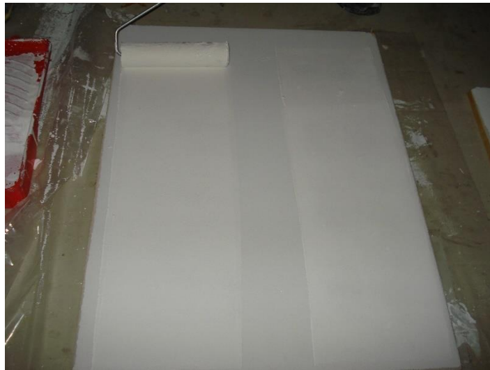
Figura 4.12 –Pormenor da pintura da amostra onde é possível ver a diferença mínima entre a cor da massa de barramento e a cor da tinta. [Fotos cedidas pelo fabricante]
