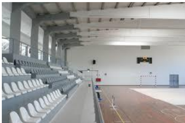
Figura 3.1 - Estrutura em betão armado (CM Portimão)
