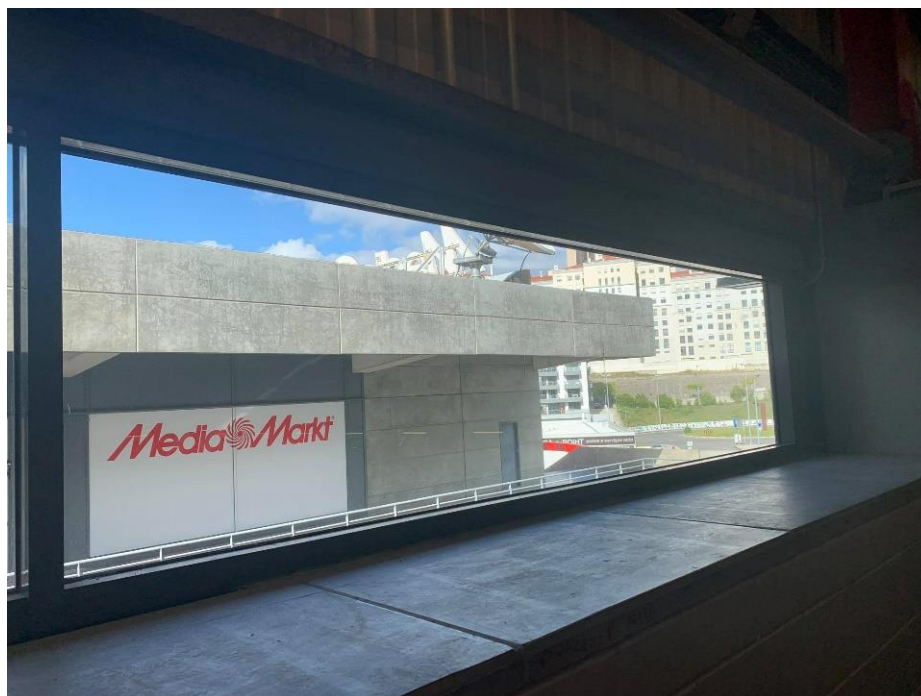
Figura 5.23 - Janelas do Pavilhão N°2
