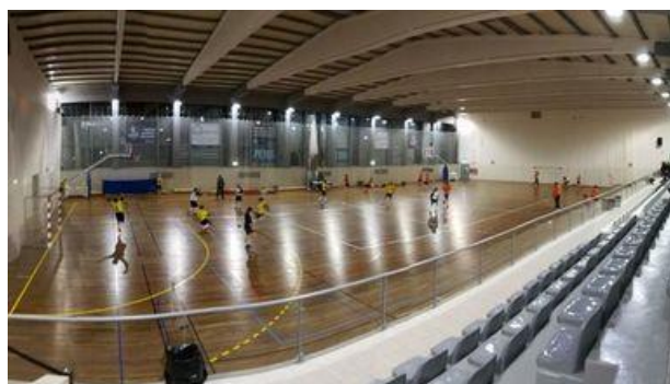
Figura 3.5 - Estrutura cobertura betão (Zerozero, Dezembro 2019)
