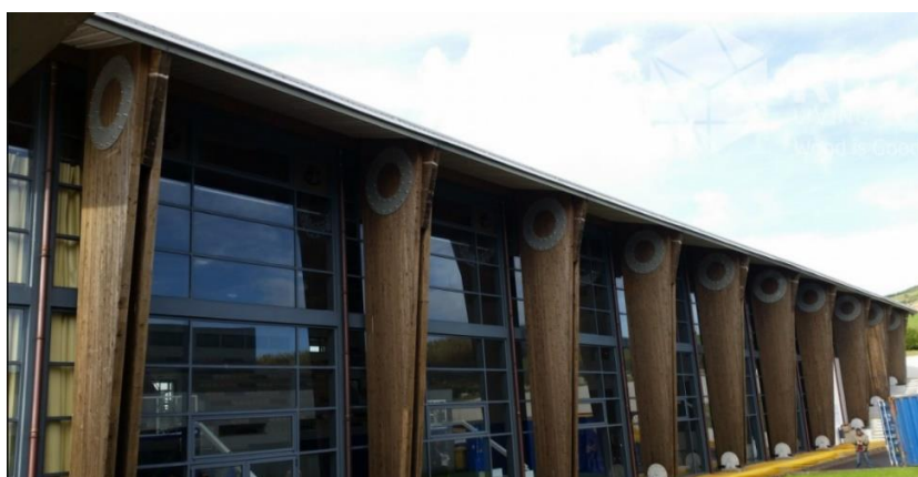
Figura 3.3 - Estrutura em madeira (R6Living)
