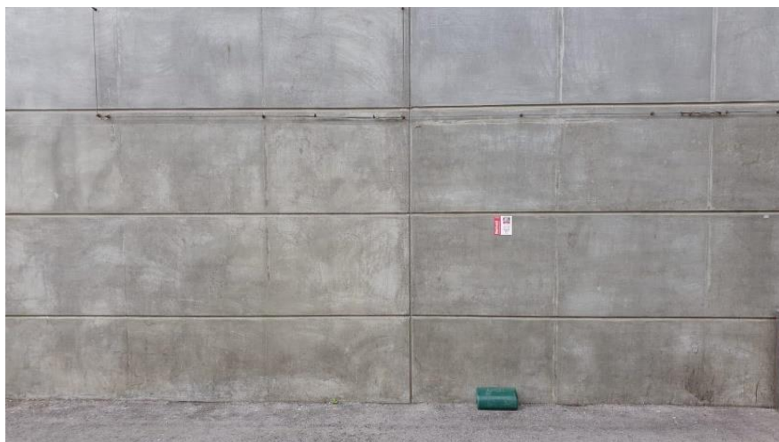
Figura 5.6 - Paredes exteriores em betão do Pavilhão Nº2
