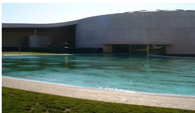
Figura 3.12 - Paredes de betão (TestGop, 8 Março 2018)
