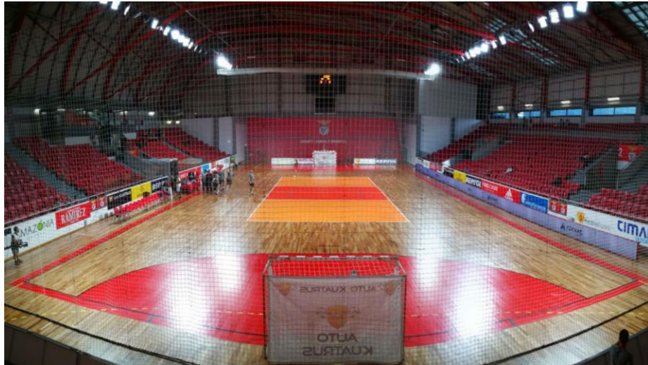
Figura 5.9 - Piso flutuante de madeira do Pavilhão N°2 (Águia, A.V.d., 2018)
