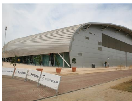
Figura 3.13 - Paredes em chapa metálica (sanduíche) (VisitAlgarve, 2018)
