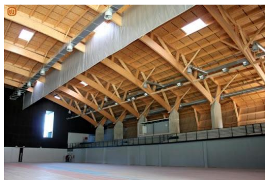
Figura 3.6 - Estrutura cobertura em madeira (R6Living)
