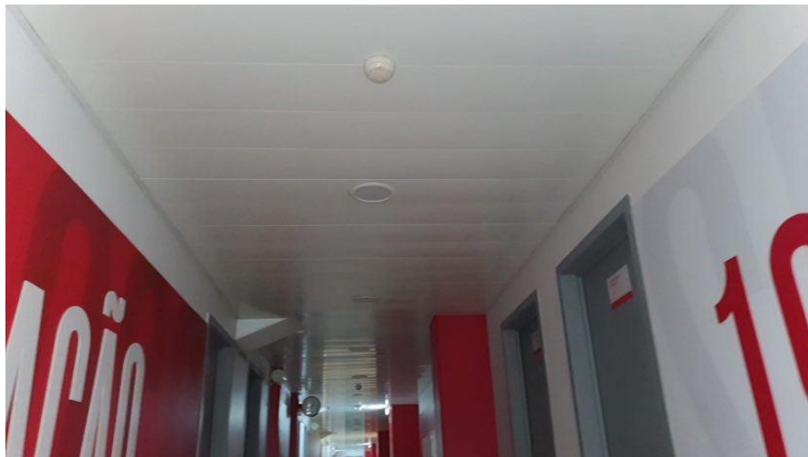
Figura 5.10 - Teto falso com painéis metálicos Pavilhão N°2
