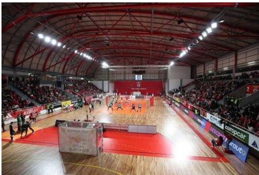
Figura 5.3 - Estrutura metálica da cobertura (Zerozero)
