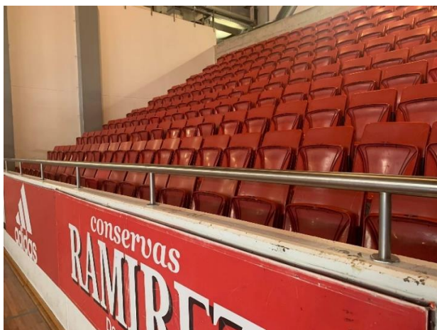
Figura 5.15 – Assentos e guardas do Pav. Nº2
