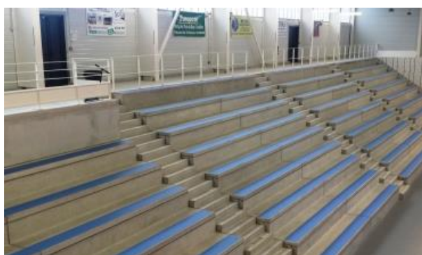
Figura 3.15 - Bancadas corridas de betão (Farcimar)
