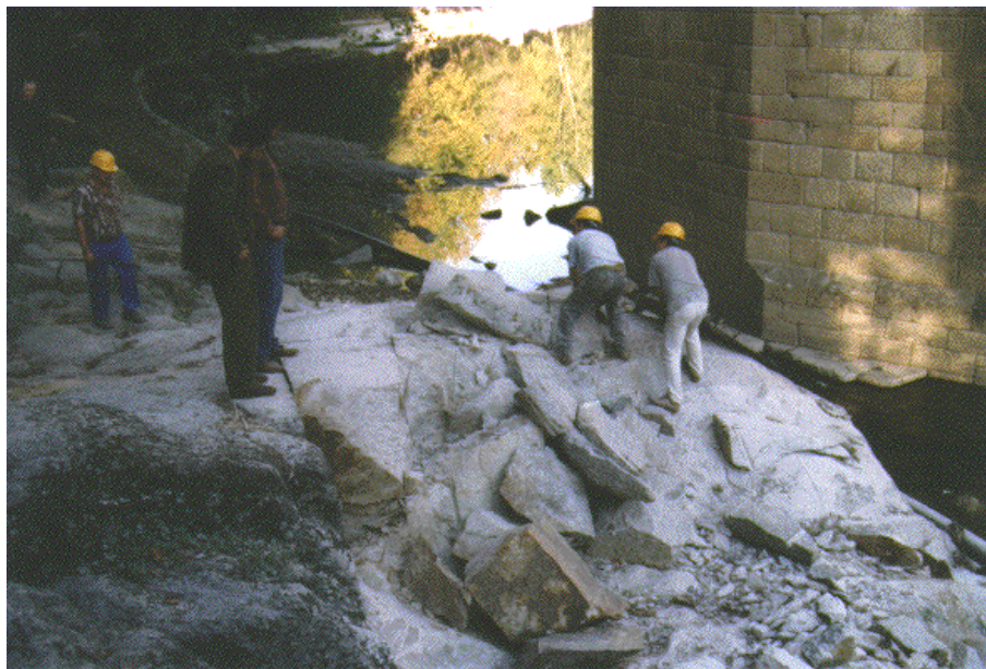
Figura 7.5 – Imagem do maciço após a aplicação das pegas de fogo correspondentes aos registos gravados.
