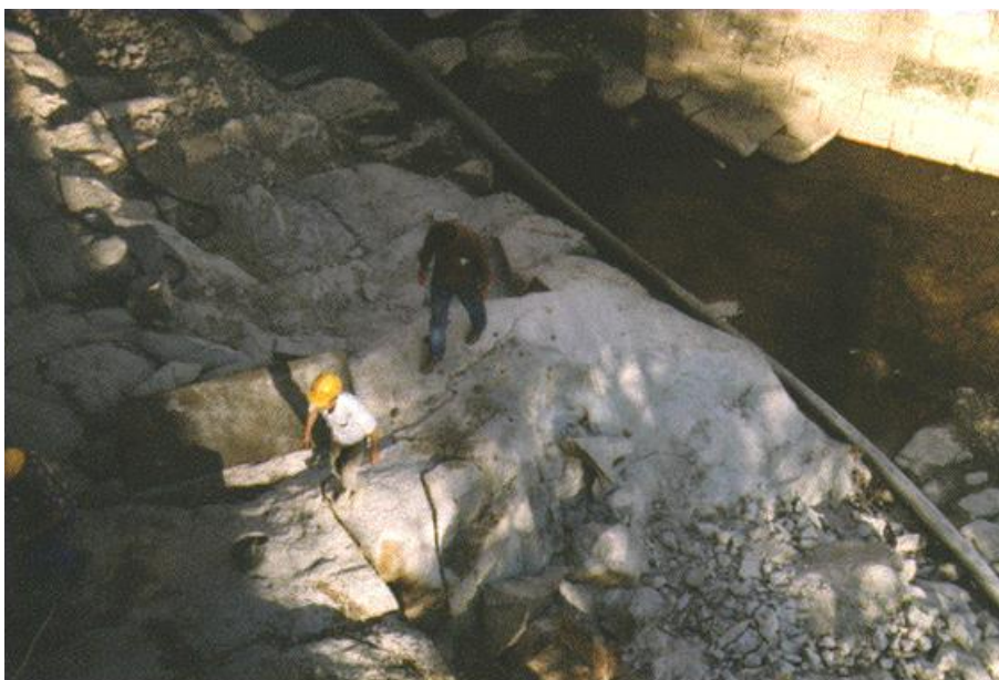
Figura 7.4 – Afloramento rochoso objeto de aplicação de pegas de fogo.
