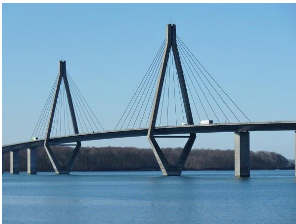
Figura 22: Ponte de Farø (Dinamarca, 1984). Exemplo de torres com formato em diamante (Kramarczik, 2012).
