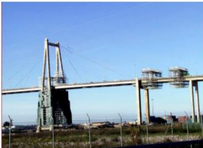
Figura 46: Vista geral da ponte em reparação e das plataformas de trabalho (Rito e Appleton, 2005).
