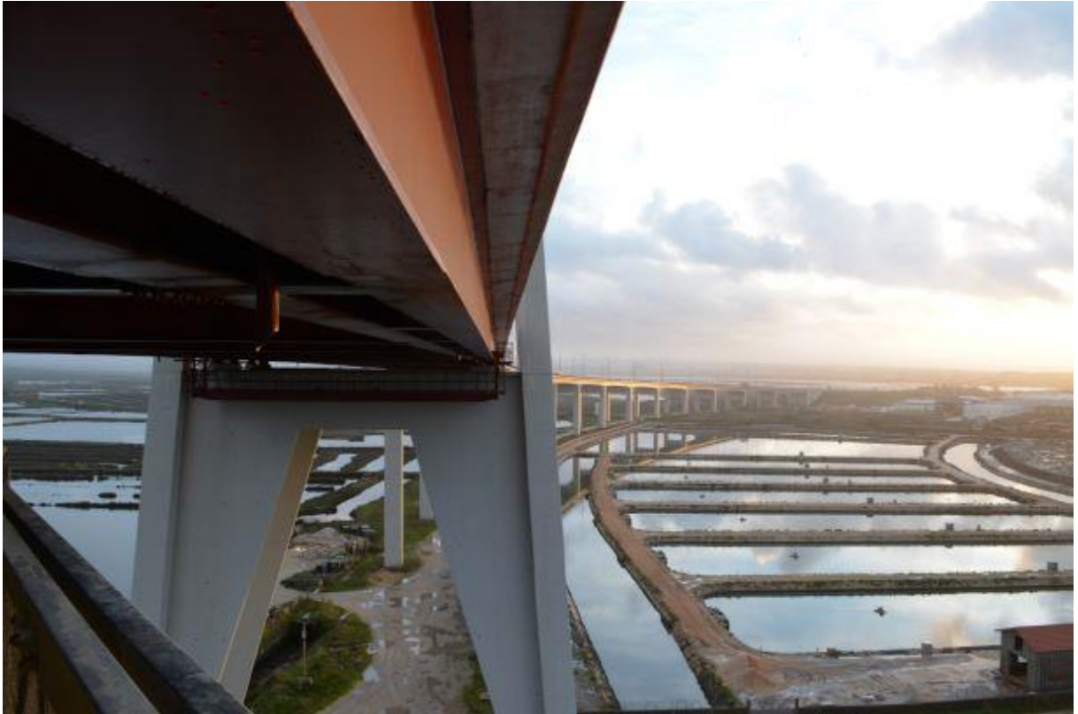
Figura 43: Vista inferior da ponte e do viaduto da margem esquerda em curva (Caetano, 2018).
