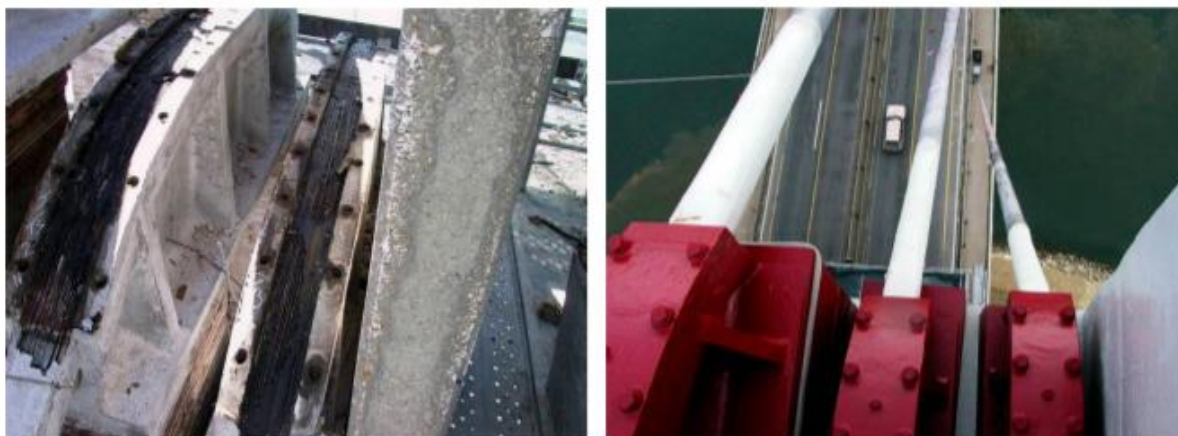
Figura 47: Reabilitação geral das selas de desvio (Rito e Appleton, 2005).
