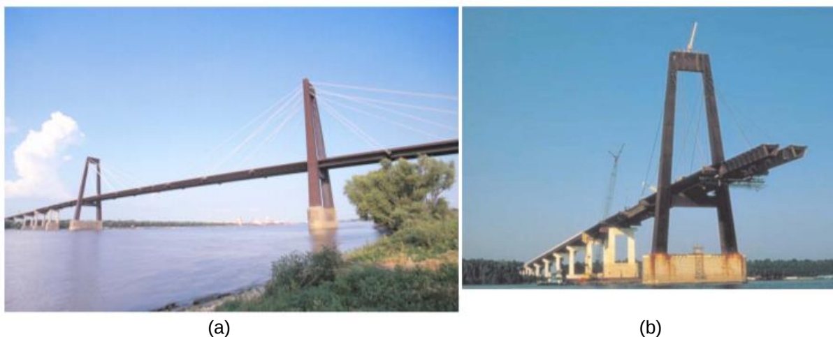
Figura 67: Ponte Hale Boggs (EUA, 1983): (a) Vista geral; (b) Detalhe das secções gêmeas do tabuleiro durante a construção (Mehrabi et al., 2010).
