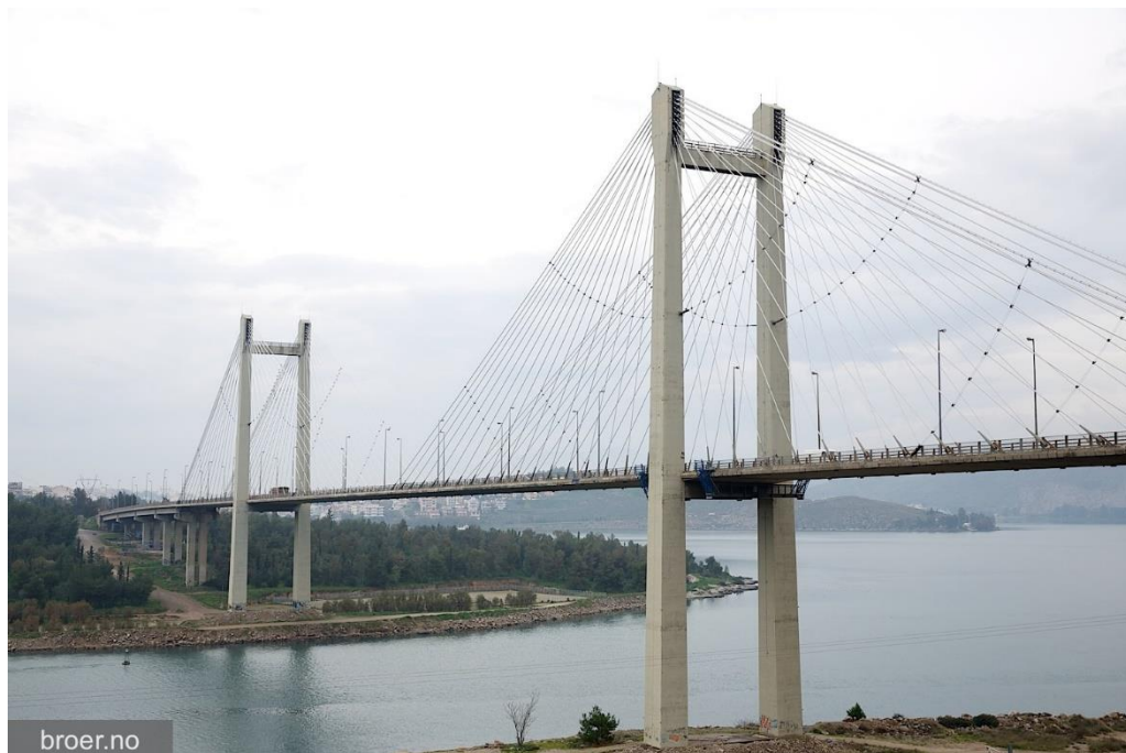
Figura 25: Ponte Evripos (Grécia, 1992). Exemplo de tabuleiro pré-esforçado com espessura reduzida (Bjertnæs, 2014).
