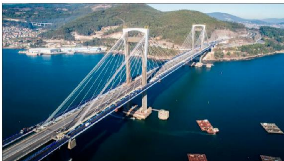
Figura 74: Ponte de Rande (Espanha, 1977). Vista geral após os trabalhos de reabilitação (Serrano-Corral et al., 2019).
