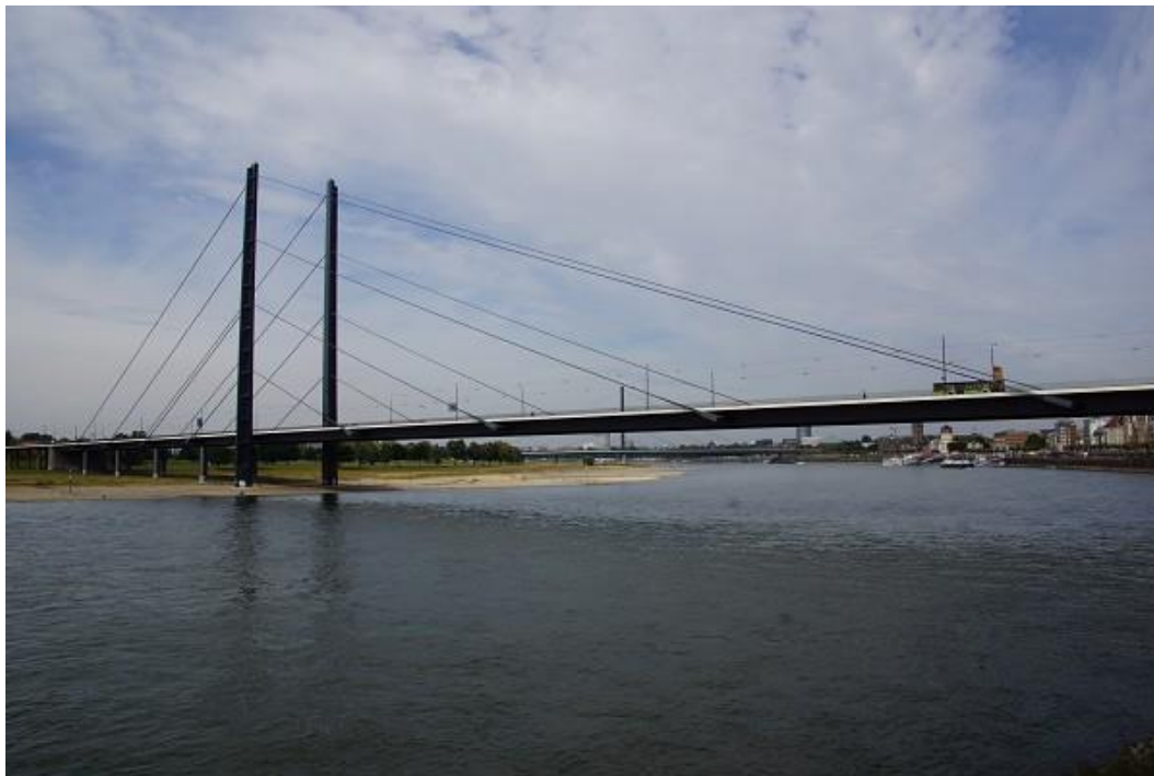
Figura 21: Ponte Kniebrücke (Alemanha, 1969). Exemplo de pilares esbeltos num sistema de suspensão lateral em harpa (Janberg, 2012).
