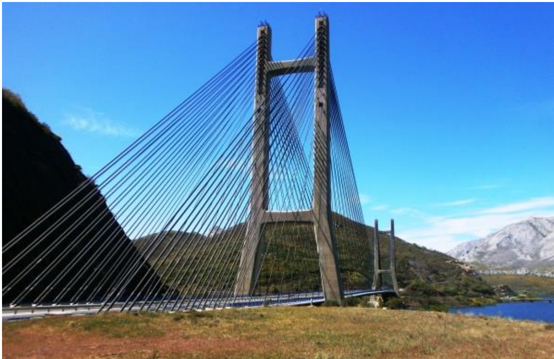
Figura 12: Ponte de Barrios de Luna (Espanha, 1983). Exemplo de um plano vertical de tirantes (Brigido, 2014).
