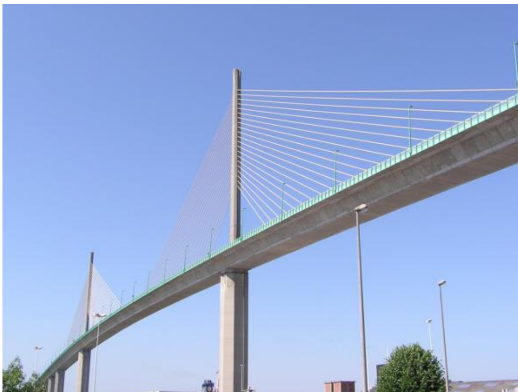
Figura 11: Ponte de Brotonne (França, 1977). Exemplo do sistema de suspensão parcial (Bourret, 2006).
