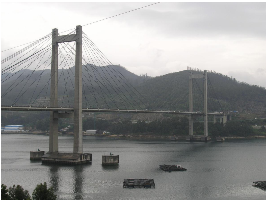
Figura 70: Ponte de Rande (Espanha, 1977). Vista geral antes dos trabalhos de reabilitação (Kanakaris-Wirtl, 2009).
