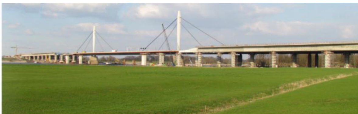
Figura 62: Ponte de Ewijk (Holanda, 1976). Vista geral antes dos trabalhos de reabilitação (Apdency, 2012).
