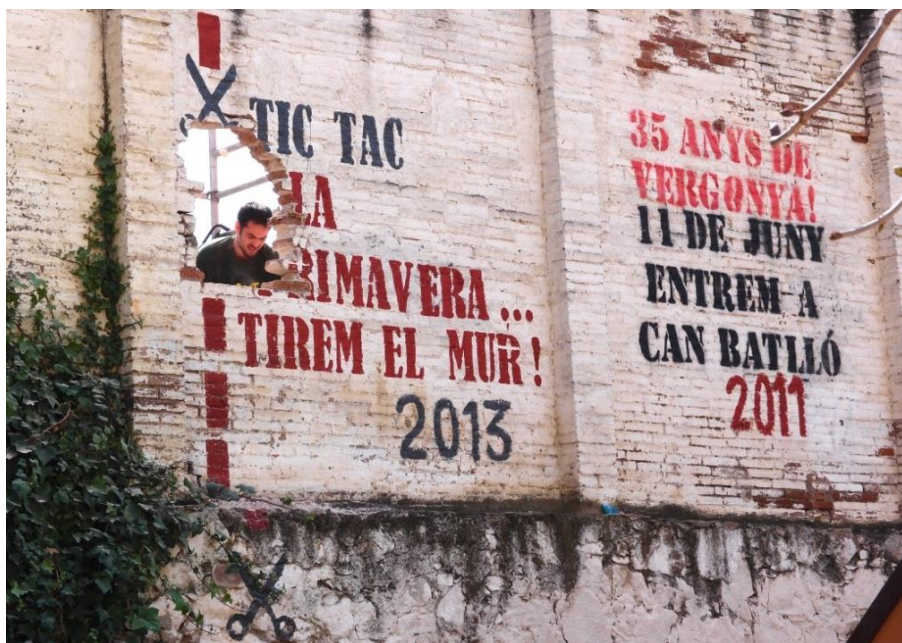
Figura 4 – Demolição do muro, para abrir Can Batlló ao acesso público Fonte: LaCol (2013)
