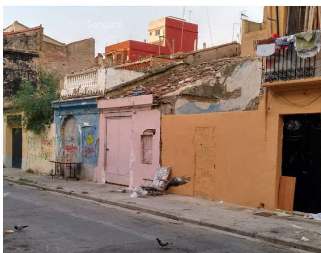
14. Estado de abandono do edificado no Cabanyal
