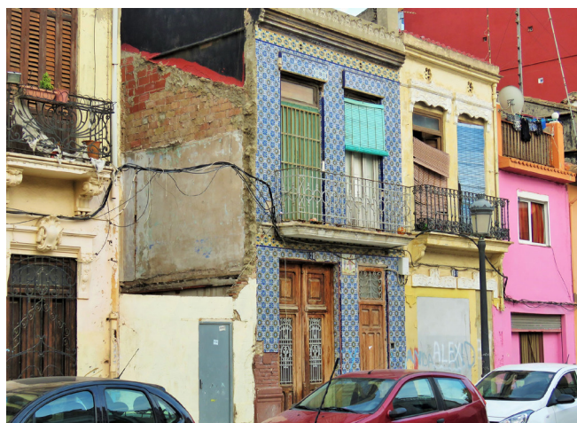
13. Estado de abandono do edificado no Cabanyal
