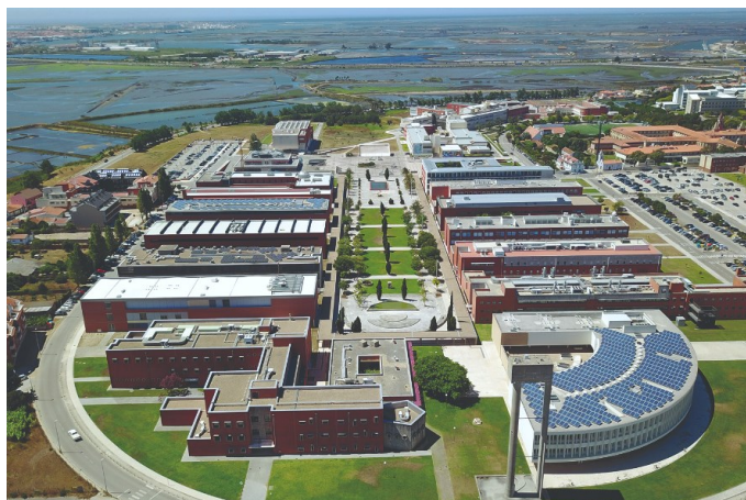
Fig.133 - Vista aérea sobre o Campus de Santiago, UA
