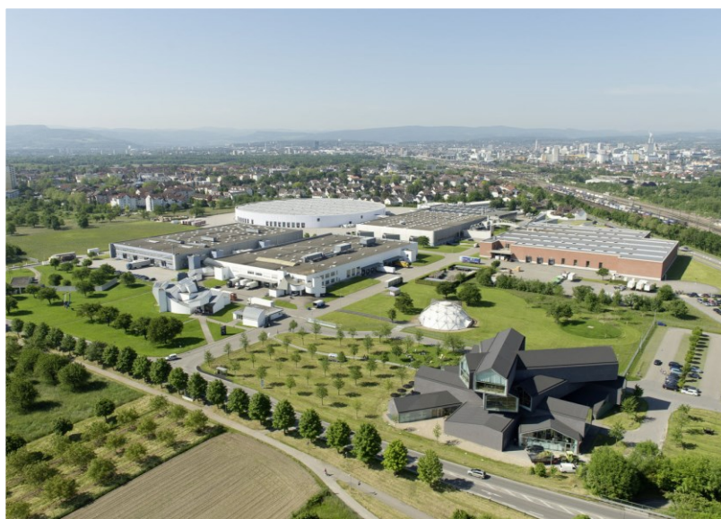
Fig.119 - Vista aérea da frente urbana do Campus da Vitra
