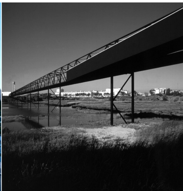
Fig.136 e 137 - Ponte Pedonal sobre o Esteiro de S. Pedro
