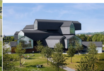
Fig.120 - Vista da VitraHaus
