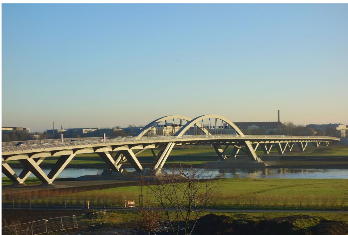
Figura 9 – Waldschlösschen Bridge (2013) de Daderot
