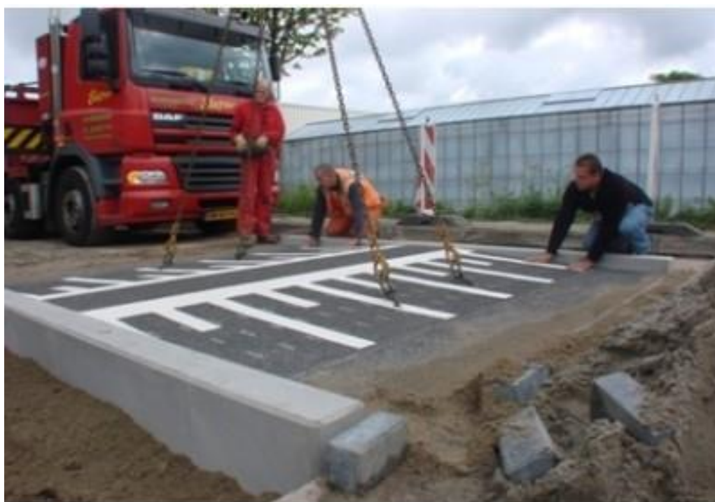
Figura 40 – Aplicação do sistema Flex-Drempel (TTS, 2020)
