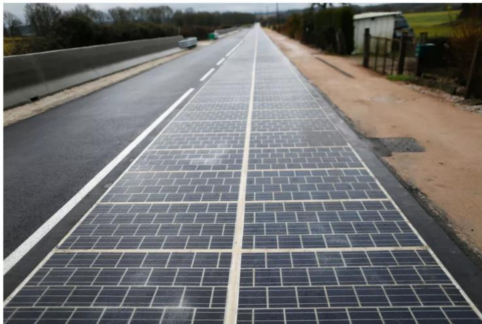
Figura 26 - 1 km de estrada com o sistema Wattway na Normandia, França (Golson, 2016)
