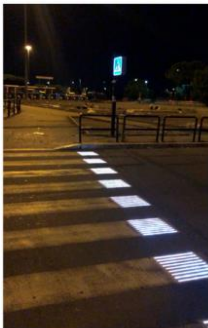
Figura 44 - Sistema de iluminação LED (Patella et al., 2020)
