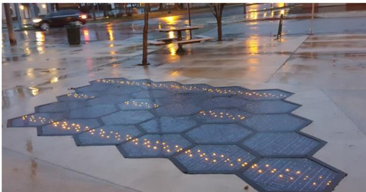
Figura 25 -Sistema Solar Roadway (Hewitt, 2018)
