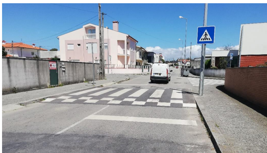
Figura 22- Passagem pedonal elevada (Autor)
