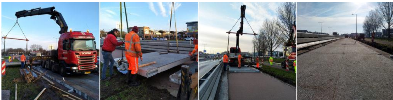
Figura 30 – Aplicação da solução SolaRoad (SolaRoad, 2020)
