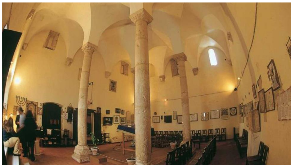
Fig. 4.8 – Interior da Sinagoga de Tomar, com visualização das abóbadas de arestas assentes nos quatro pilares, as mísulas, os vários elementos interiores decorativos e a disposição dos lugares sentados (antes das obras de beneficiação) [33].
