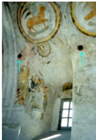
Fig. 3.8 – Dois dos vasos acústicos da igreja de Villetle, Suíça (apontados com duas setas) [11].
