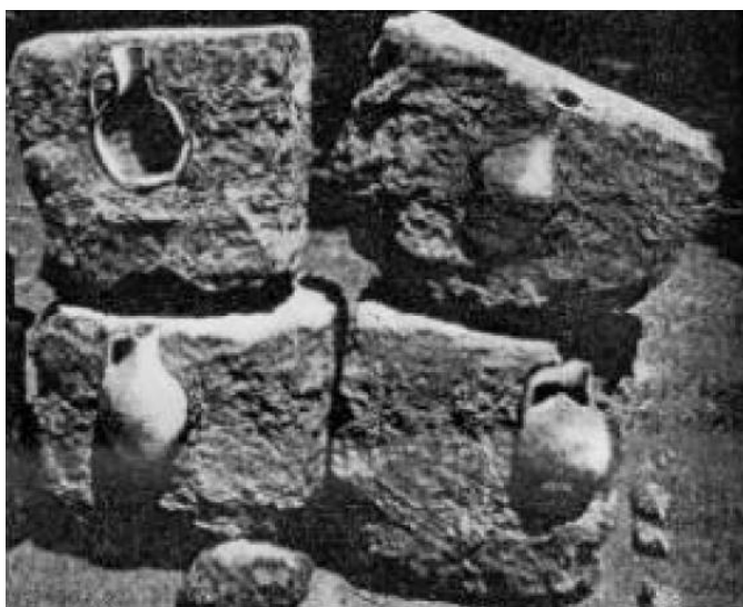
Fig. 3.4 – Vasos acústicos embutidos em blocos de pedra [11].
