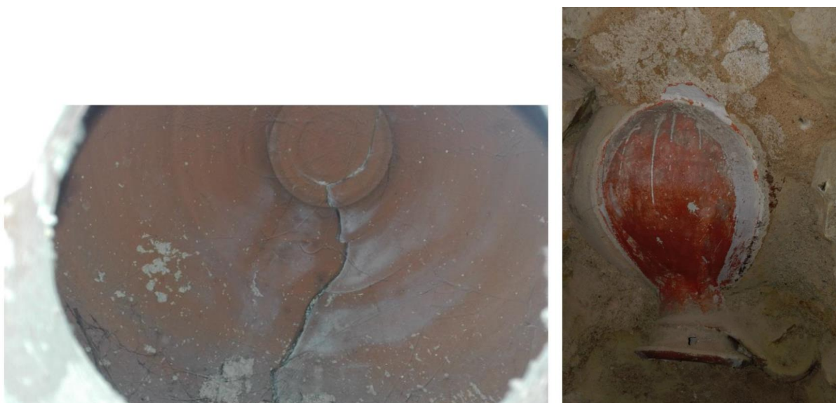
Fig. 4.10 – Vasos acústicos da Sinagoga de Tomar: à esquerda o interior de um dos vasos; à direita um dos vasos a descoberto [22].
