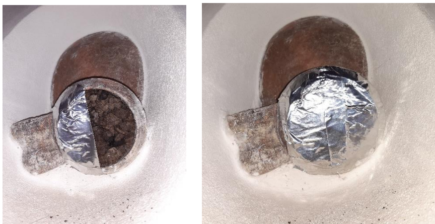
Fig. 5.3 – Oclusão dos vasos acústicos, com recurso a "tampões" de aglomerado negro de cortiça e revestidos exteriormente a folha de alumínio [fotos da autora].
