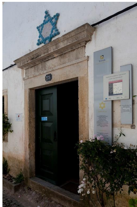
Fig. 4.6 – Fachada principal da Sinagoga de Tomar, antes das obras de beneficiação [19].
