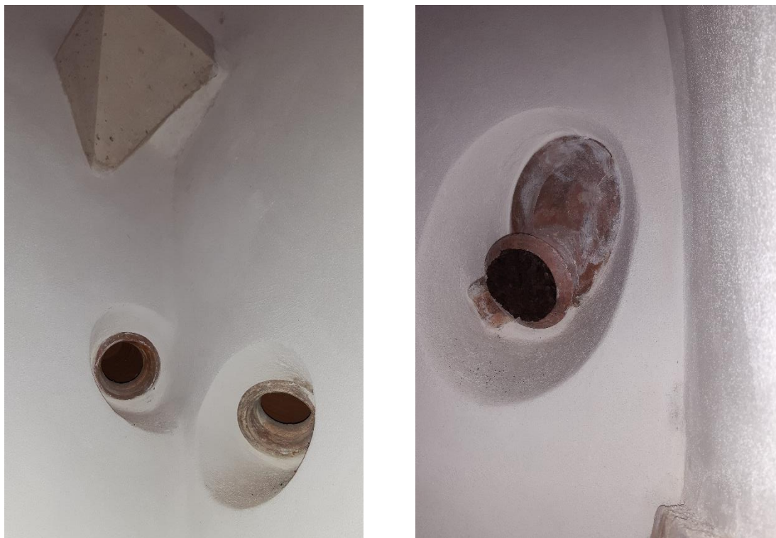
Fig. 4.9 – Três dos vasos acústicos da Sinagoga de Tomar, virados para baixo, com os orifícios a apontar para o interior [fotos da autora].
