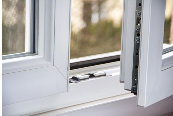
Figura 9 - Exemplo de caixilharia em PVC [9]
