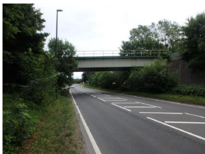
Fig. 4.1 - Vista geral da ponte ferroviária de Eastington Road (Rail, 2017).
