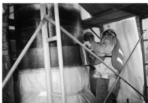
Fig. 2.35 - Adaptação sísmica de um pilar tubular de aço, Hanshin Bridge, Japão (Kitada et al., 2003).
