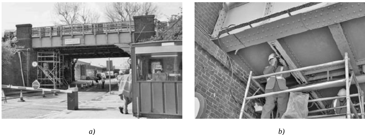
Fig. 2.34 - Vistas do reforço estrutural da ponte de Acton Bridge: a) Vista geral da ponte; b) Aplicação de FRP numa viga secundária (Moy e Bloodworth, 2007).
