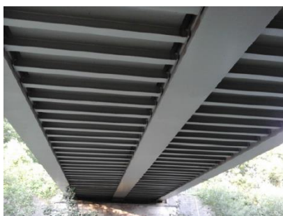
Fig. 4.2 - Vista inferior do tabuleiro (Rail, 2017).
