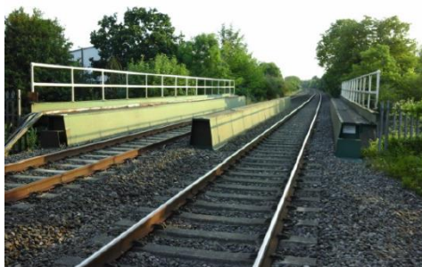
Fig. 4.3 - Vista superior do tabuleiro (Rail, 2017).
