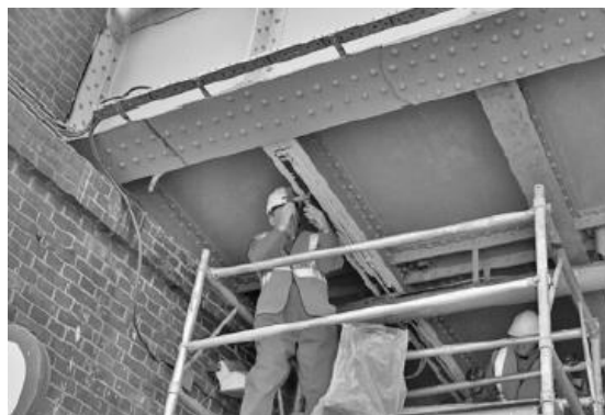
Fig. 2.34 - Vistas do reforço estrutural da ponte de Acton Bridge: a) Vista geral da ponte; b) Aplicação de FRP numa viga secundária (Moy e Bloodworth, 2007).
