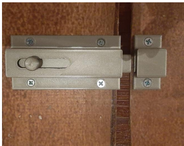
Figura 94 – Fecho montado e aparafusado, completamente funcional
