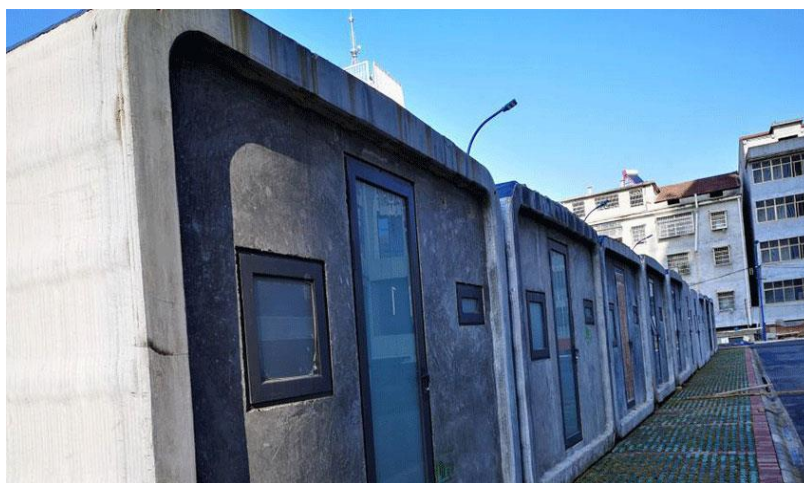
Figura 35 - Casas de isolamento social de emergência impressas em 24 horas da Winsun [60]
