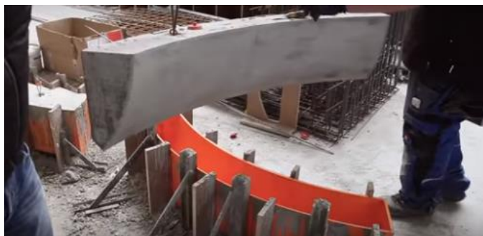
Figura 30 - Segmento de uma das caixilharias de betão, depois de ser retirado da cofragem impressa em 3D [53]
