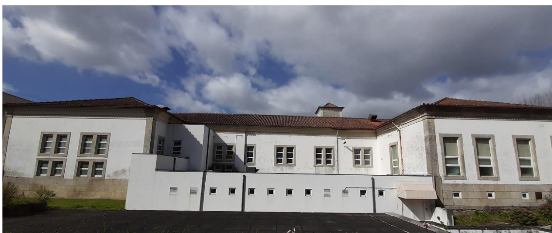
Figura 2.14 – Paredes exteriores do edifício existente
