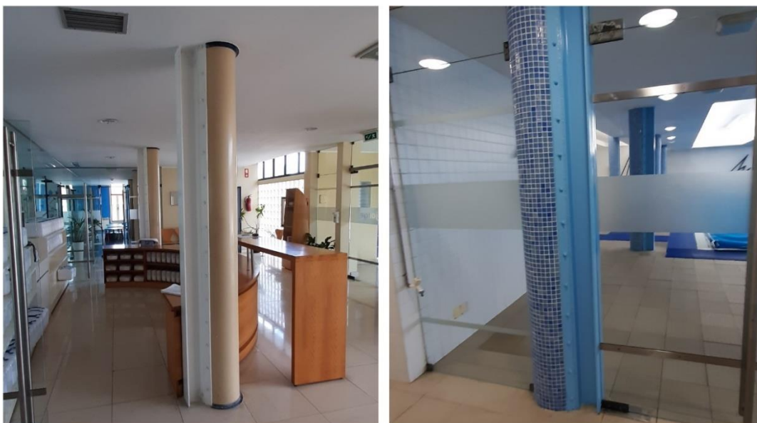
Figura 2.12 – Perfis metálicos ancorados aos pilares do 1º piso (esquerda) e da cave (direita)
