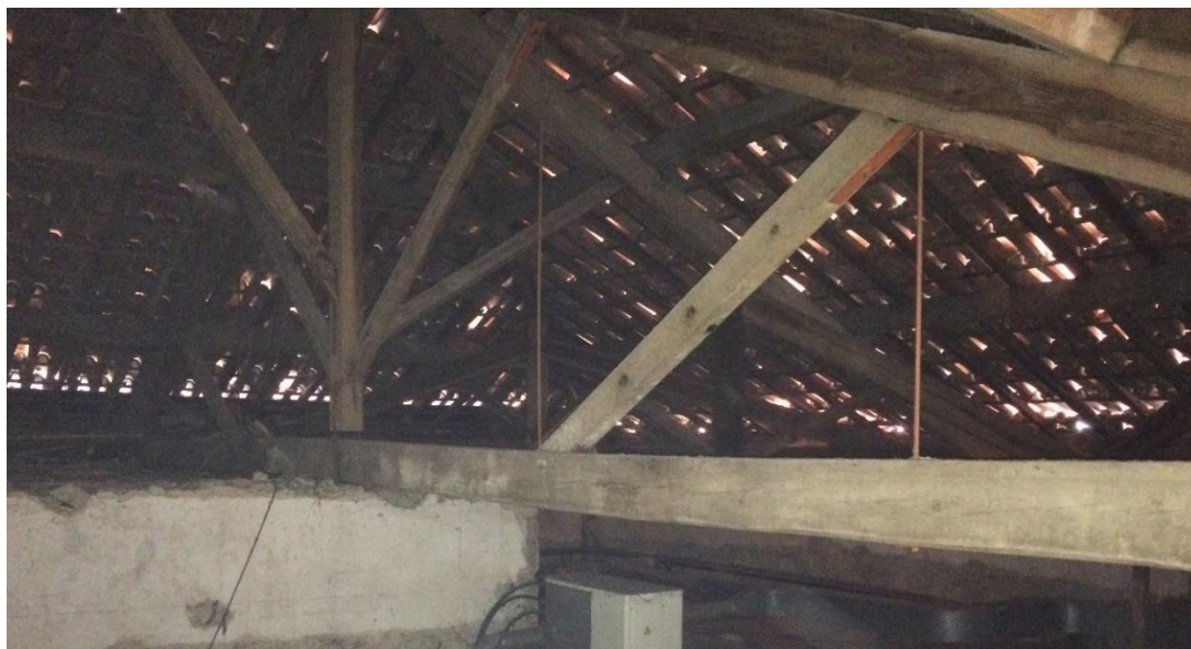
Figura 3.38 – Asna da cobertura inclinada (07/02/2019 – cortesia Eng. Diogo Oliveira)
