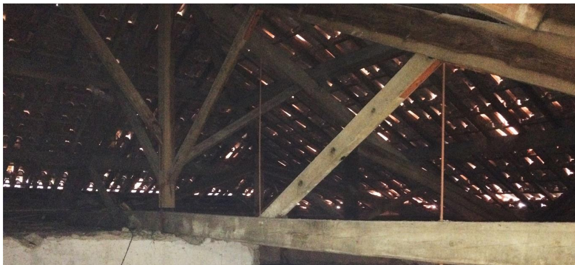
Figura 2.15 – Interior da cobertura inclinada (07/02/2019 – cortesia Eng. Diogo Oliveira)
