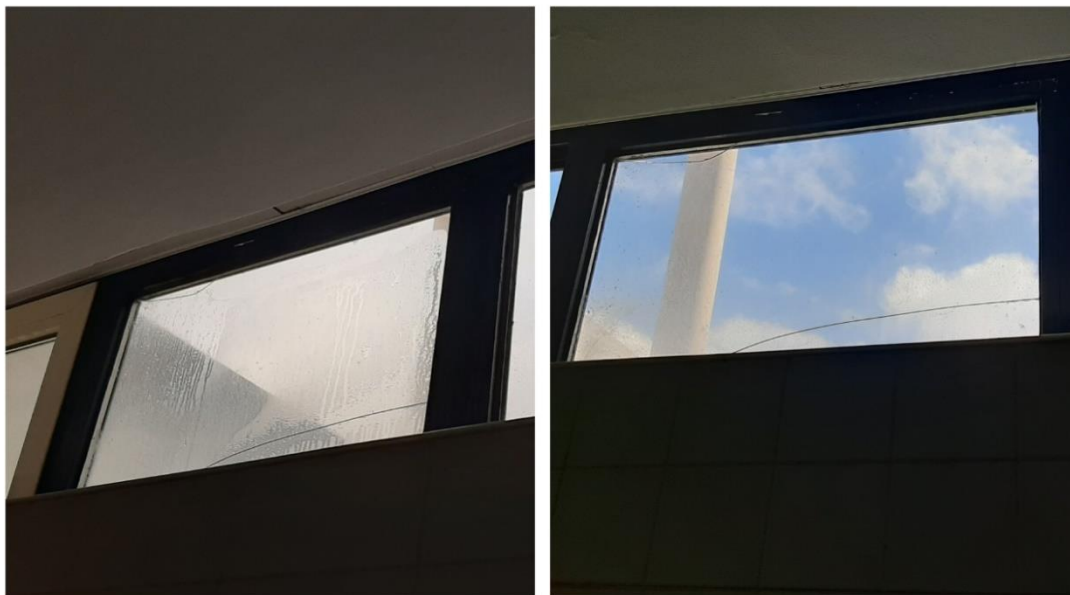
Figura 3.6 – Vidro partido (esquerda: 05/03/2020; direita: 11/05/2020)
