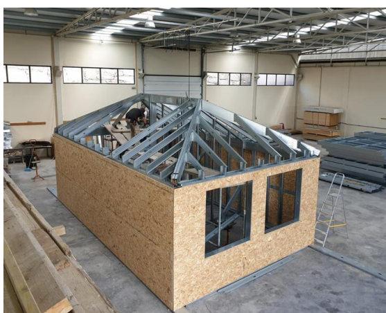
Figura 6.5 - Sistema LSF: a) Montagem da estrutura em fábrica; b) Elevação e execução da estrutura em obra. Fonte, [44]
