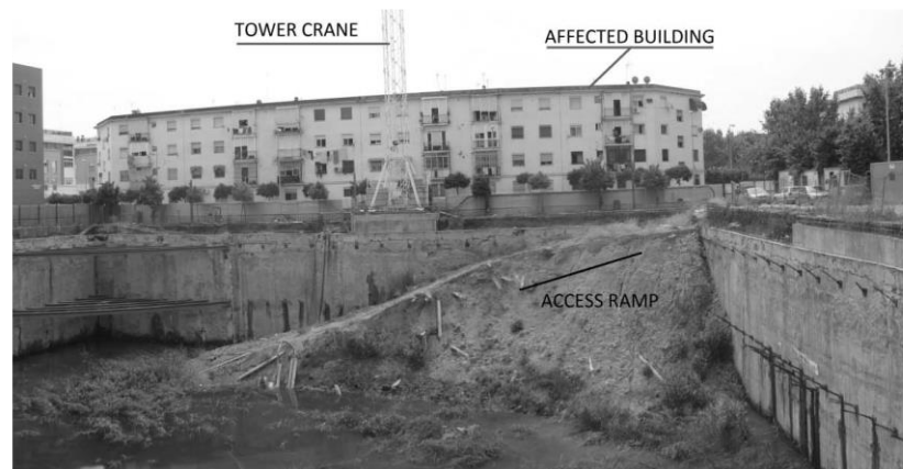
Figura 2.2 - Edifícios alvo de estudo e escavação no terreno adjacente, antes do acidente, [18]
