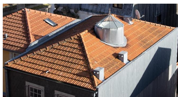
Figura 3.8 - Conjunto de coberturas: a) Telhados de duas águas; b) Telhados de quatro águas. (Fotos do Autor)
