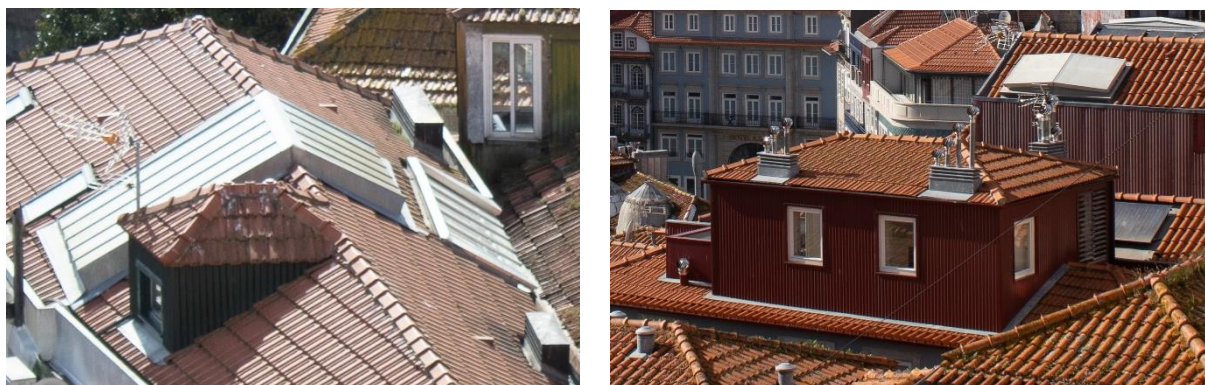
Figura 3.9 - Águas furtadas: a) trapeira; b) mirante. (Foto do autor)
