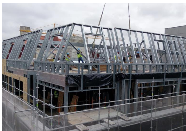
Figura 6.5 - Sistema LSF: a) Montagem da estrutura em fábrica; b) Elevação e execução da estrutura em obra. Fonte, [44]
