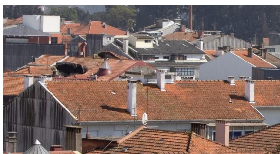
Figura 3.8 - Conjunto de coberturas: a) Telhados de duas águas; b) Telhados de quatro águas. (Fotos do Autor)
