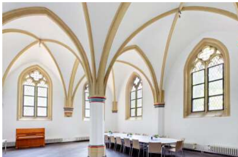
Figura 6.13 - Exemplo de paredes e tetos com acabamento estanhado Sonacoustic [52].
