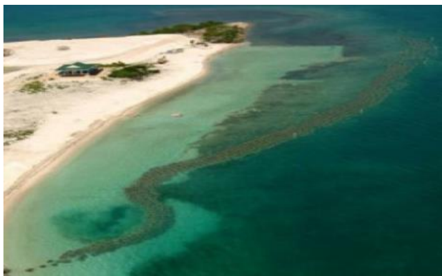
Fig. 20 - Exemplo de quebramar submerso (Google).
