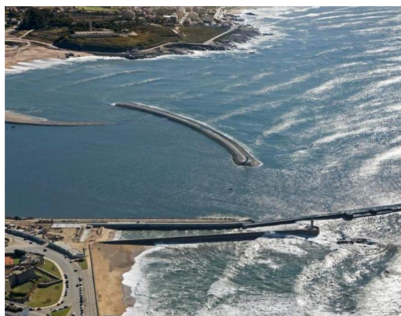
Fig. 19 - Quebra-mar destacado da embocadura do rio Douro (Cavaco, 2020).
