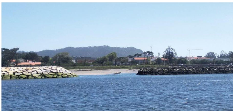
Fig. 56 - Estado atual dos troços do Dique.
