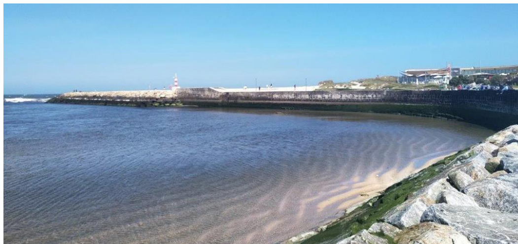
Fig. 49 - Molhe Norte da embocadura do rio Cávado, estado atual.
