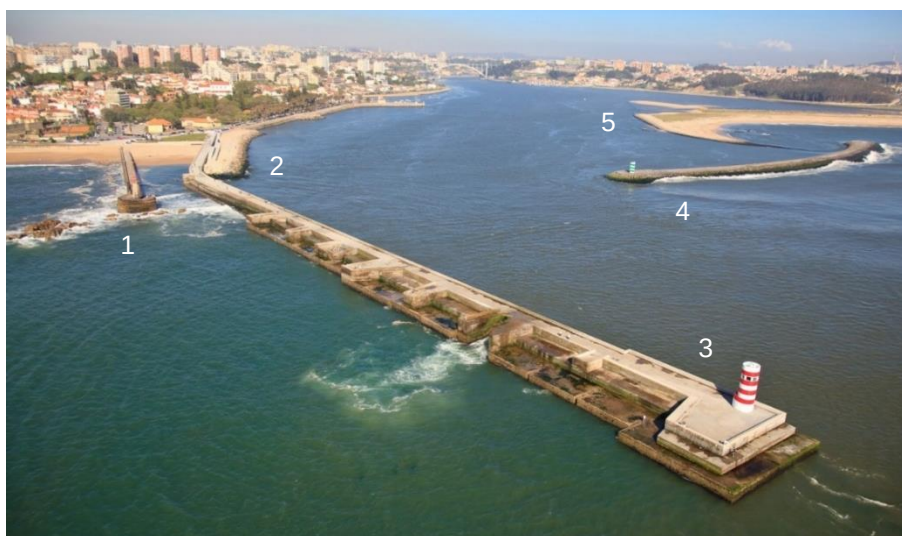
Fig. 11 - Fotografia aérea da embocadura do rio Douro: 1) molhe de Felgueiras; 2) molhe do Touro; 3) molhe Norte; 4) quebramar destacado; 5) cabedelo (Cristino, 2020).
