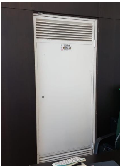
Figura 4.11 - Porta existente na zona técnica do elevador
