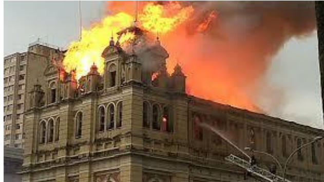
Figura 2.2 - Incêndio no Museu da Língua Portuguesa [15]
