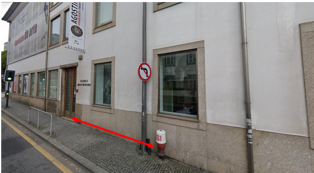
Figura 4.5 - Localização do Marco de Incêndio na Rua do Conselheiro Veloso da Cruz
