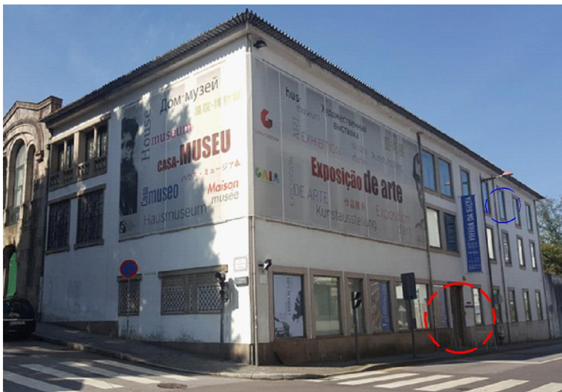
Figura 4.3 - Pontos de penetração na fachada da Rua do Conselheiro Veloso da Cruz
