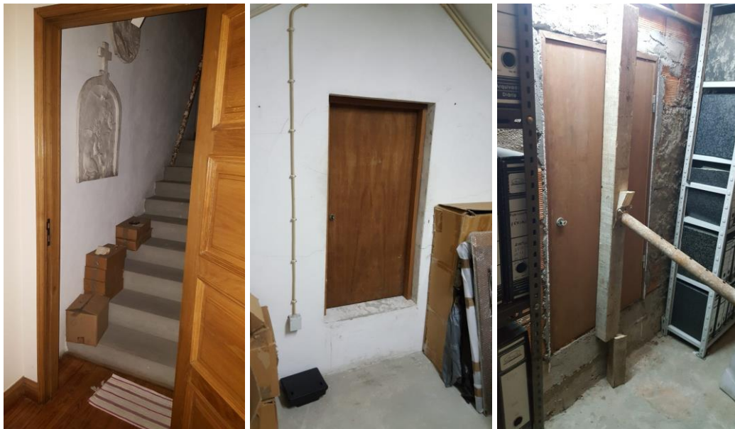
Figura 5.5 - Portas existentes nas zonas referidas do aproveitamento de vão de cobertura
