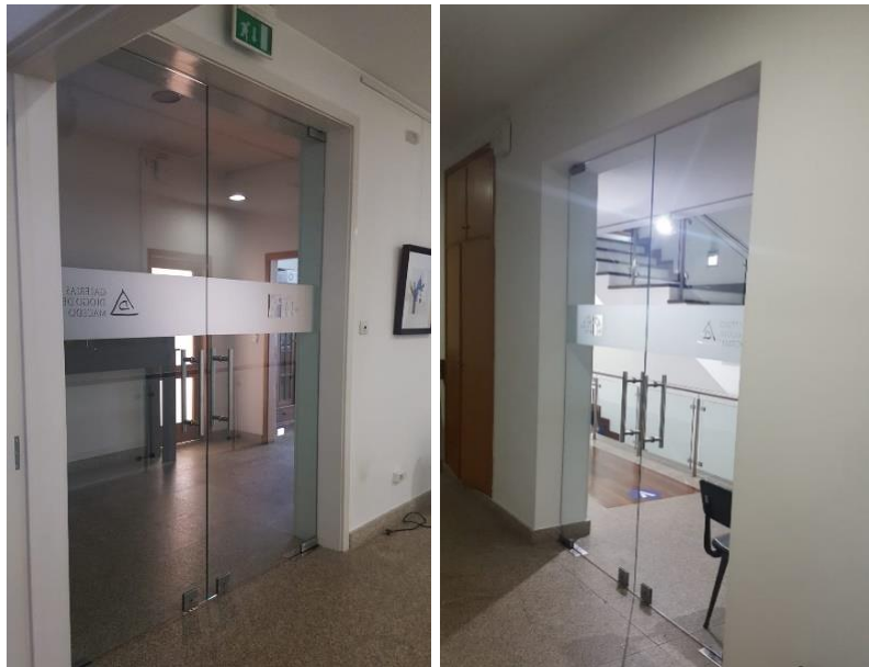
Figura 5.4 - Portas existentes na separação das duas unidades nos pisos 2 e 3
