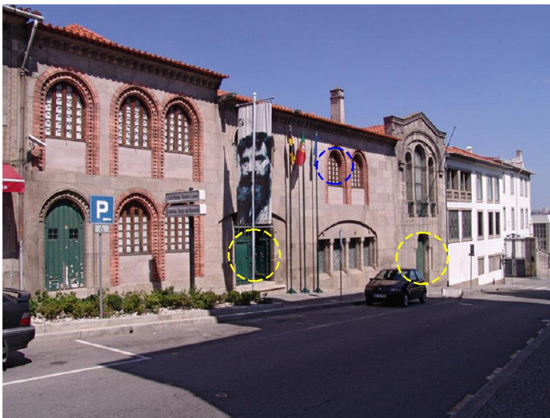
Figura 4.2 - Pontos de penetração na fachada da Rua Teixeira Lopes
