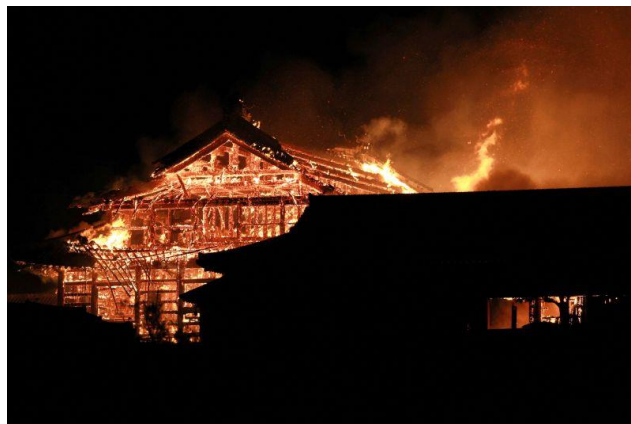
Figura 2.6 - Incêndio no Castelo de Shuri [19]
