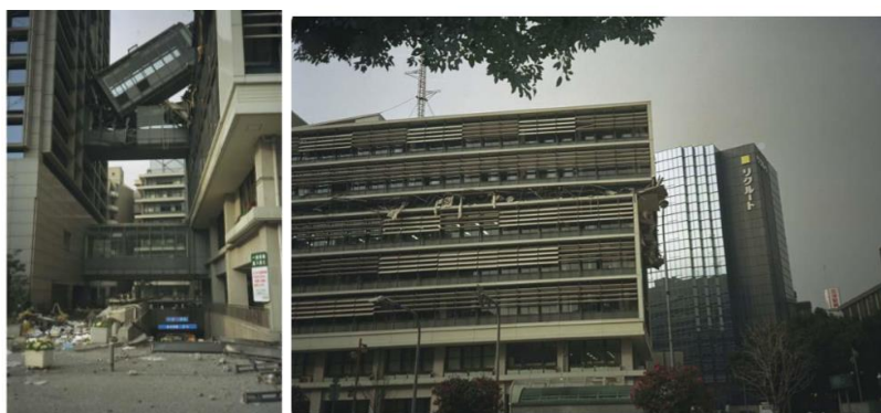
Figura 1.5 - Caso de colocação de elementos a ligar duas estruturas (à esquerda) e altura diferentes entre pisos e elementos não estruturais (à direita). Localização: Kobe - Japão, 1995
