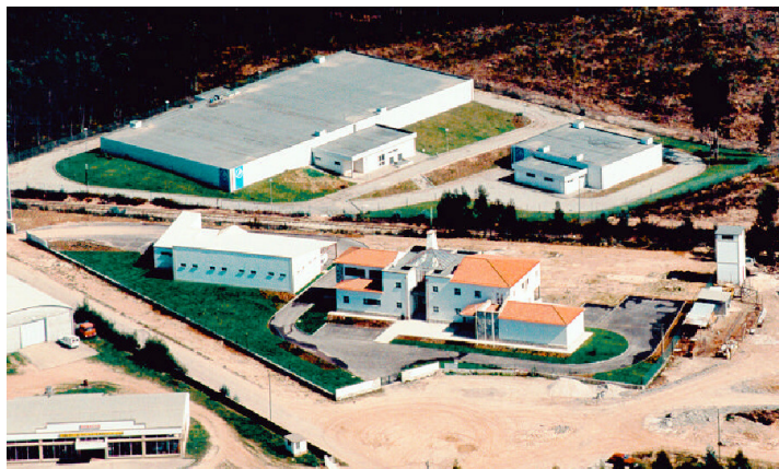
Figura 4.5 - Edifício de Exploração e reservatórios RPA e R2
