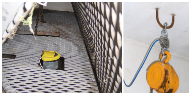
Figura 6.17 - Transdutor de nível ultra-sónico e célula de carga
