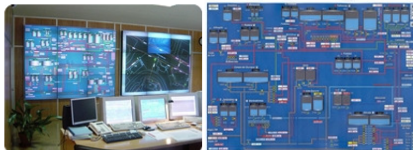
Figura 4.8 - Centro de comando e layout da supervisão
