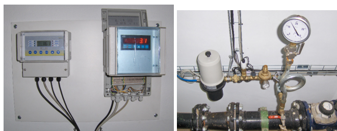
Figura 6.11 - Transdutor de condutividade e de turvação
