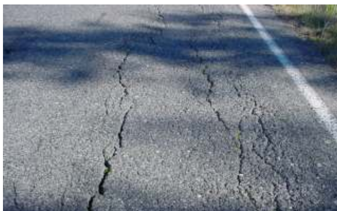
Figura 5.5 – Abatimentos e pele de crocodilo
