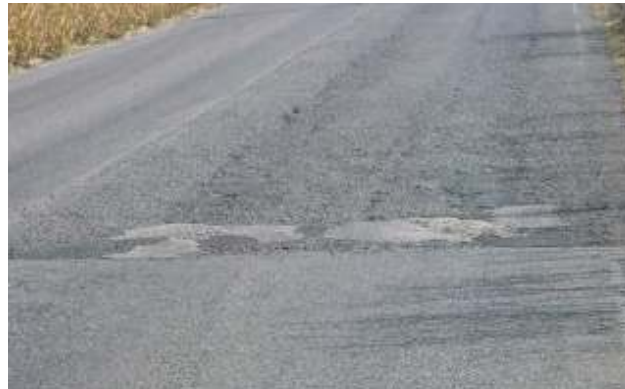
Figura 5.3 – Distinção entre a colocação de diferentes camadas de desgaste
