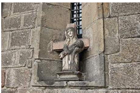
Figura 97 - Santa de pedra na fachada do Mosteiro de São Gonçalo, Amarante (fotografia própria F.Iglesias)
