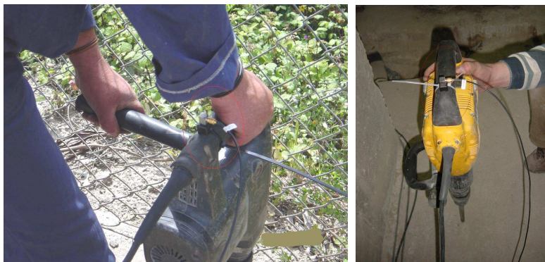
Figura 3.6.5 – Localização dos acelerómetros nos equipamentos.
