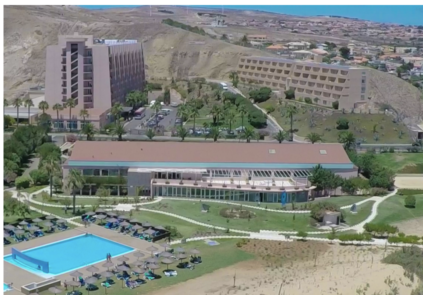
Figura 3.2: Fotografia aérea atual do complexo hoteleiro
