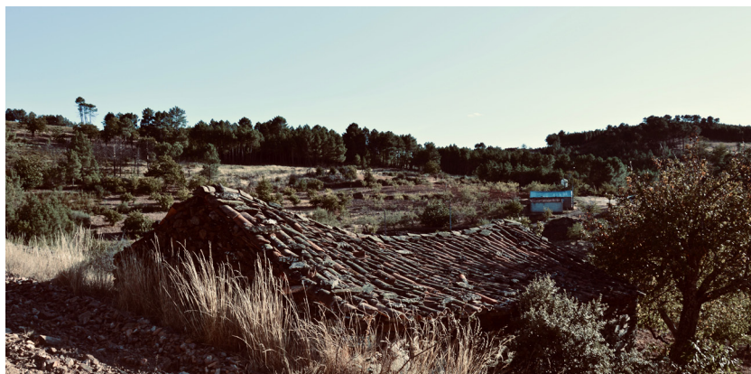
3.b Integração da construção no terreno, Quinta da Macieirinha
