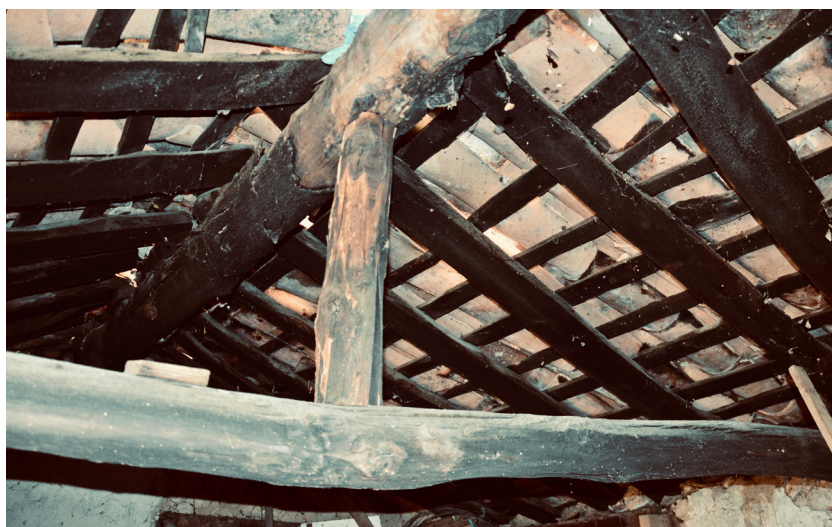
29 Cobertura com estrutura de madeira vista pelo interior, Quinta da Macieirinha
