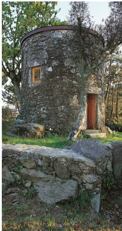
7 Moinho em Vilar de Mouros 8 Cobertura
