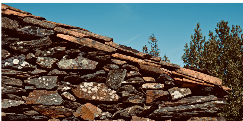
3.h Remate das telhas com a parede, Quinta da Macieirinha
