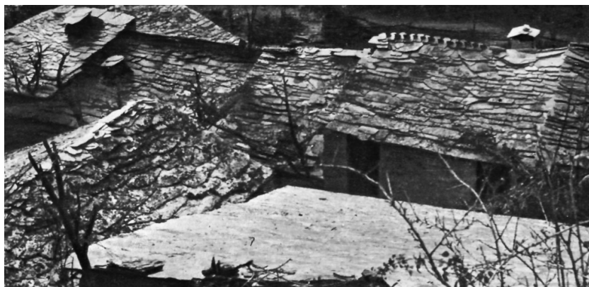
4 Vista das coberturas, Guadramil
