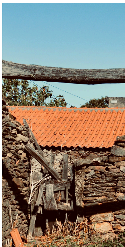
10.i Transição entre o pátio interior e a zona do coberto
