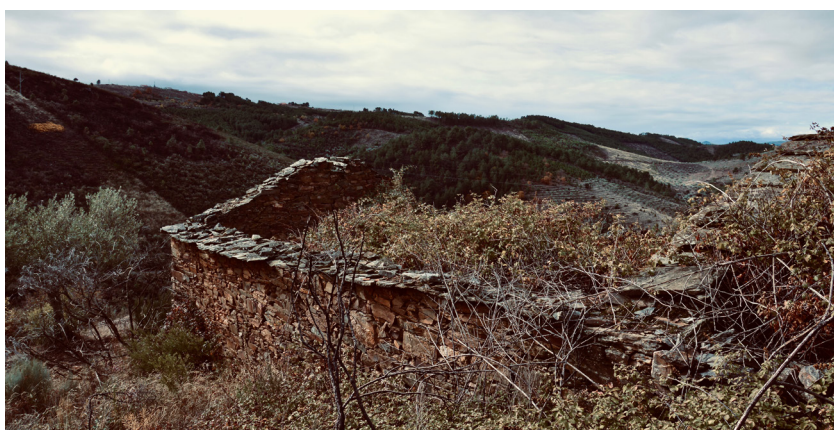
3.i Uso de lâminas de xisto em coberturas, Quinta da Endrineira
