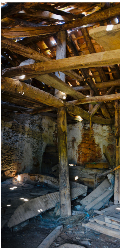
7.c Telha vã
