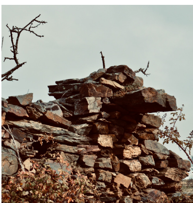
3.f Cobertura do forno, Quinta do Cabeço de Barro
