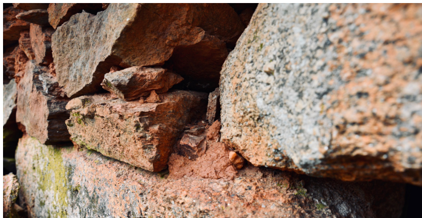
5.b Argamassa de barro na padieira da porta da oficina
