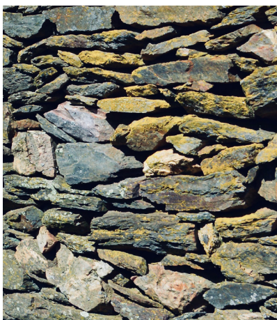
3.e Xisto na parede sul do palheiro
