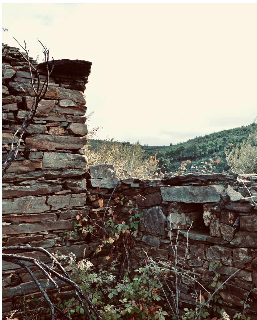
25 Aumento de muro, Quinta da Endrineira
