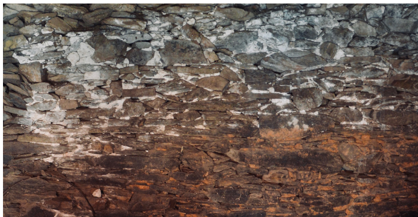
5.c Utilização de argamassa no interior da oficina
