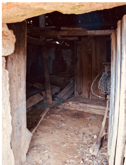
62 Vista para o interior da Oficina
