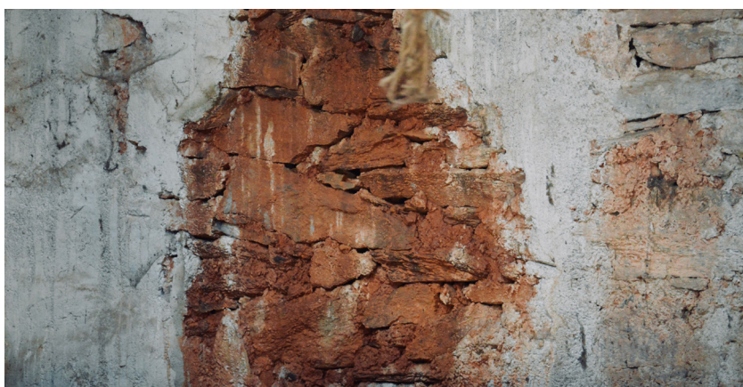
5.f Sobreposição de camadas de argamassa
