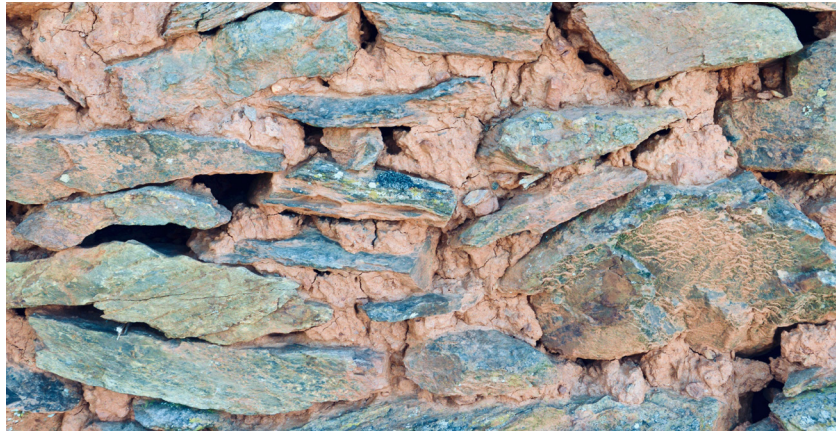
5.a Argamassa na parede este da oficina
