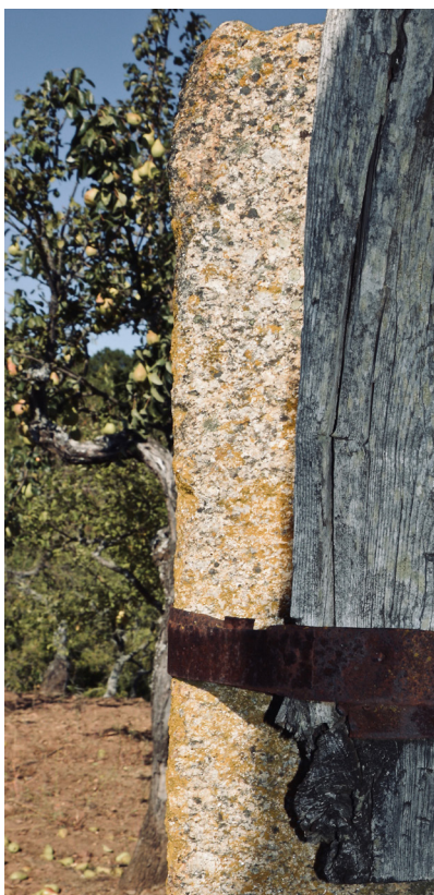
8.g Estrutura existente do coberto exterior
