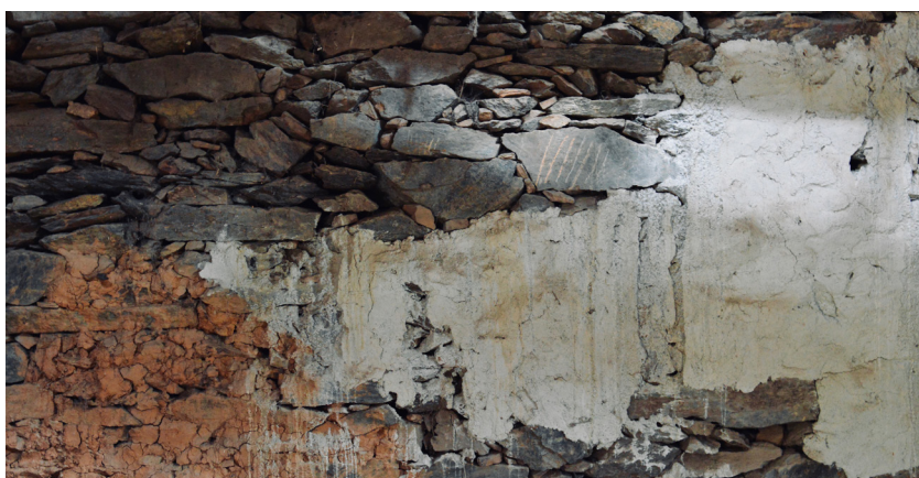
5.e Parede de xisto, argamassa de barro e cal na divisória entre a oficina e a habitação
