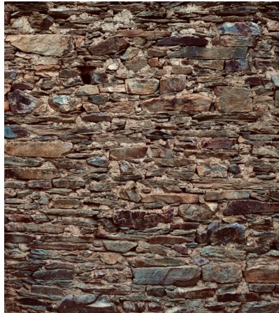
6.a Argamassa de cal e barro, Quinta do Cabeço de Barro
