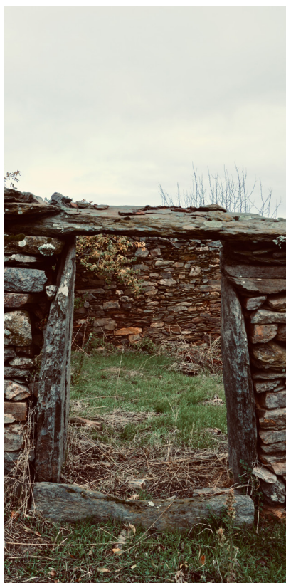
2.g Vão sem desenho de elementos de remate, Quinta do Vale dos Arcos
