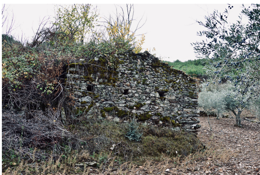
28 Vãos na fachada, Quinta do Vale dos Arcos
