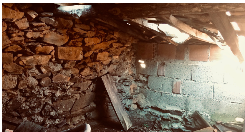
74 Encontro entre materiais mais recentes e a parede pré-existente
