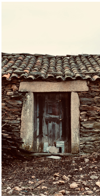
2.a Vão com elementos em granito, Quinta da Endrineira
