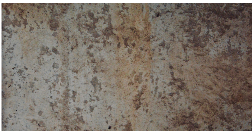
5.d Reboco interior na habitação
