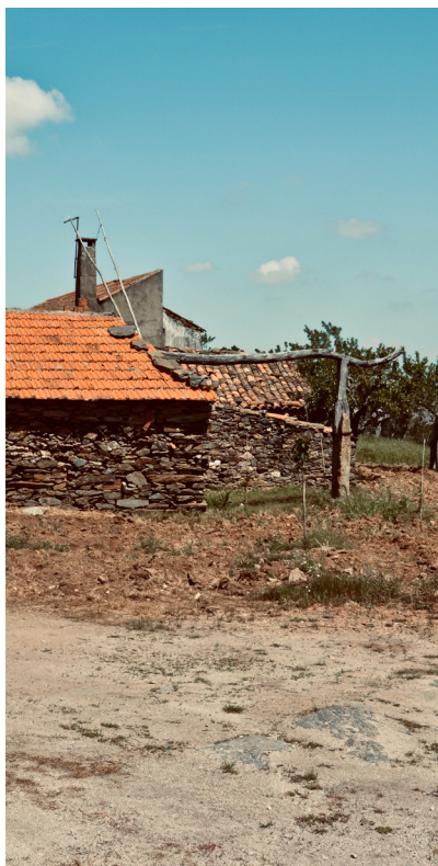
8.a Destaque da estrutura do coberto
