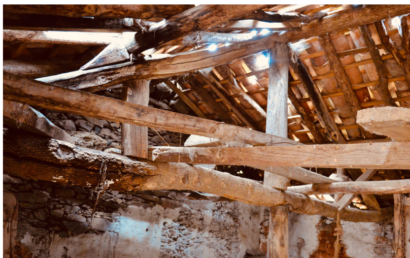
64 Estrutura original de cobertura em madeira
