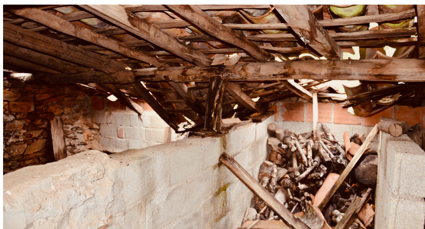
72 Simples apoio da estrutura da cobertura da pocilga
