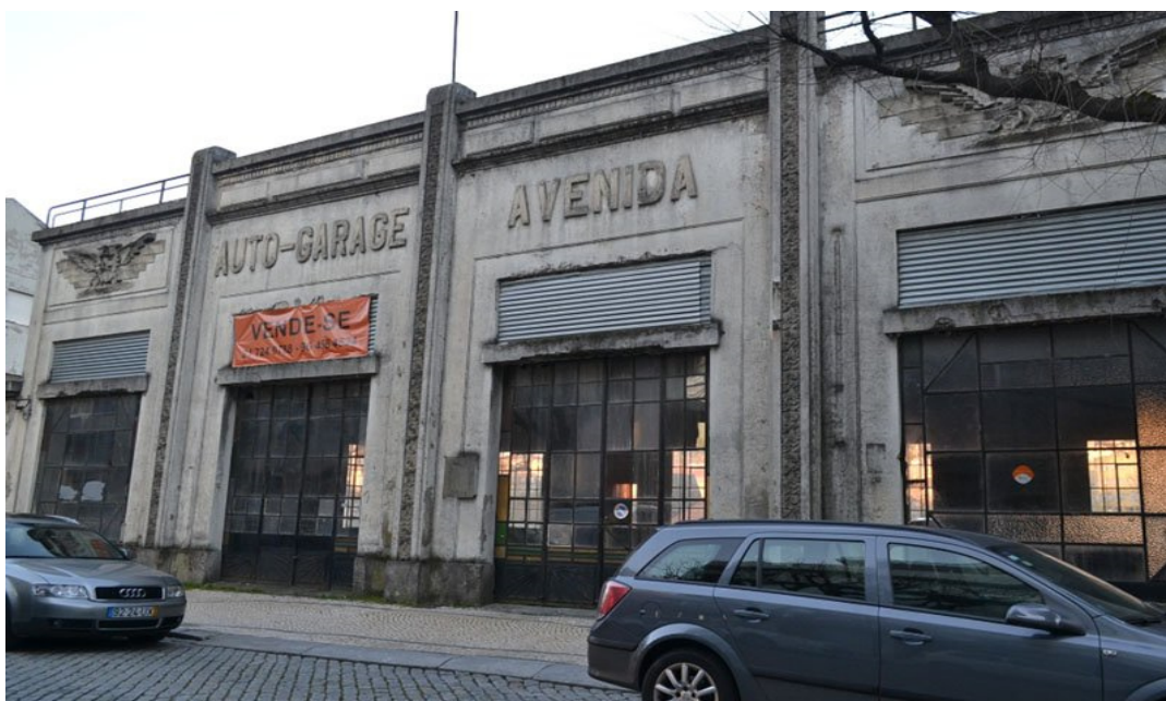
Fig. 4.5. – Fachada da Garagem Avenida antes da intervenção. [64]
