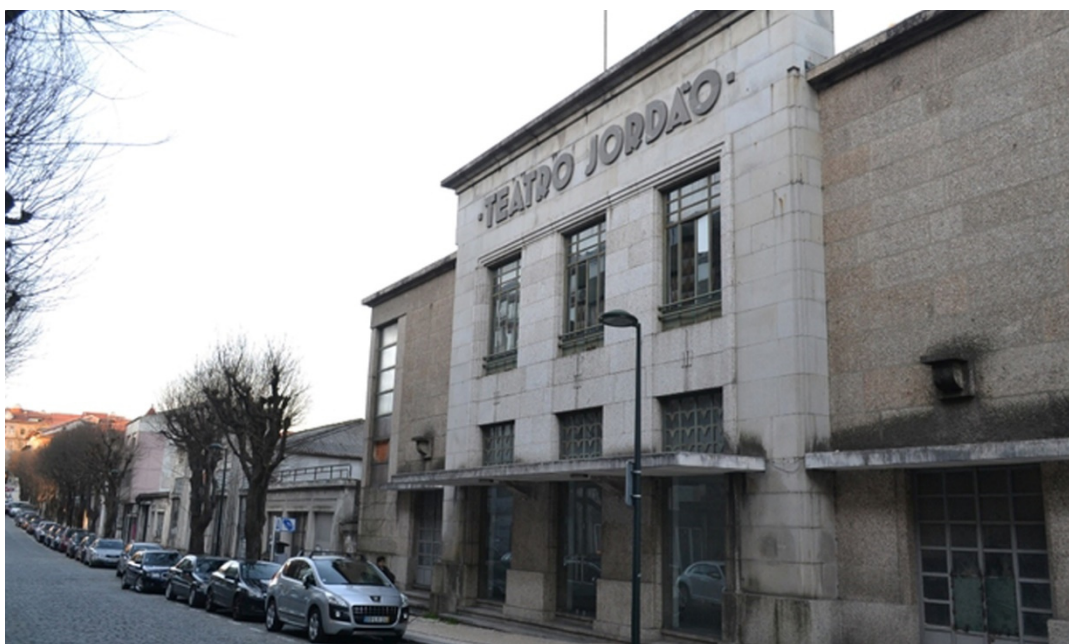
Fig. 4.4. – Fachada do Teatro Jordão antes da intervenção. [65]
