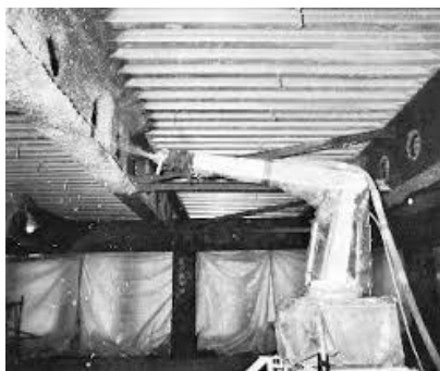
Figura 3.15 - Robô de spray de isolamento corta-fogo, desenvolvido pela empresa japonesa Shimizu.
