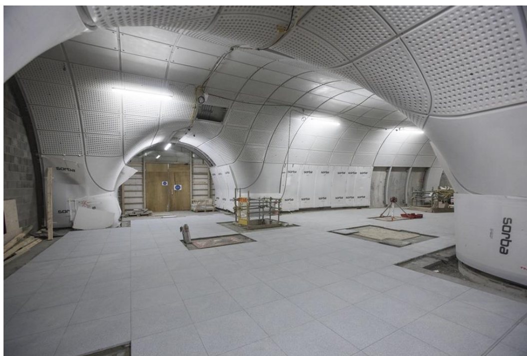
Figura 4.13 – Tuneis de acesso às estações em construção, onde é visível a colocação dos componentes de revestimento em GRC.
