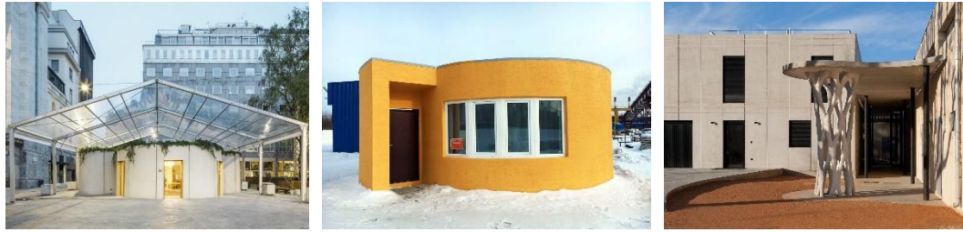
Figura 3.22 – Projetos protótipos, desenvolvidos por empresas para demonstrar a suas tecnologias de deposição em betão. Cybe (esquerda); Apis Core (centro); XtreeE (direita).
