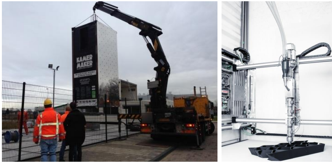
Figura 4.29 – Máquina de extrusão de plástico “Kamermaker”, que pode trabalhar junto ao local de obra.
