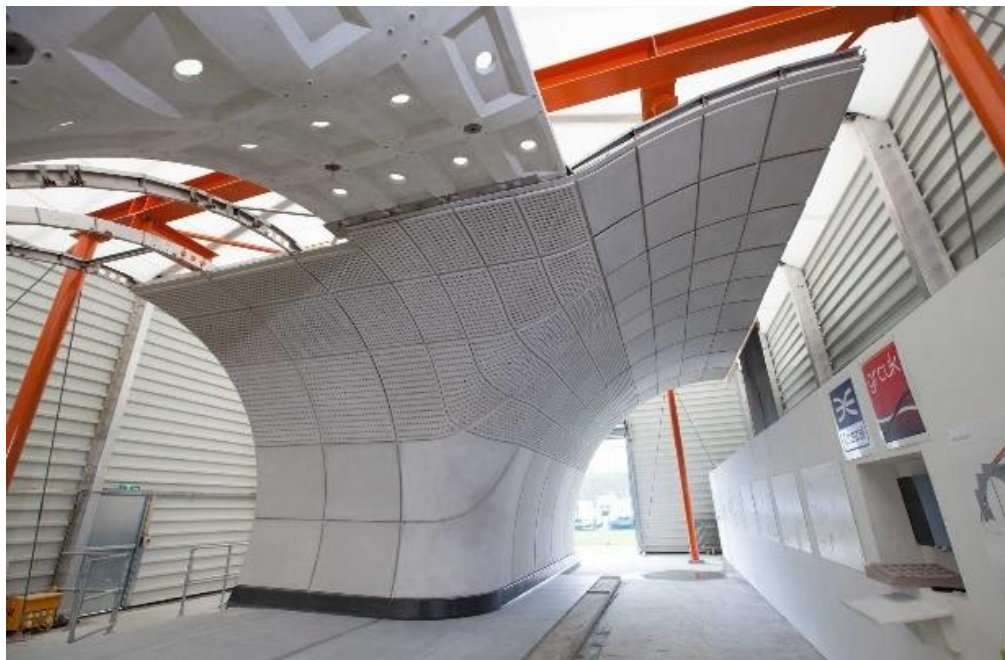
Figura 4.12 – Maquete à escala real para testar a solução construtiva.
