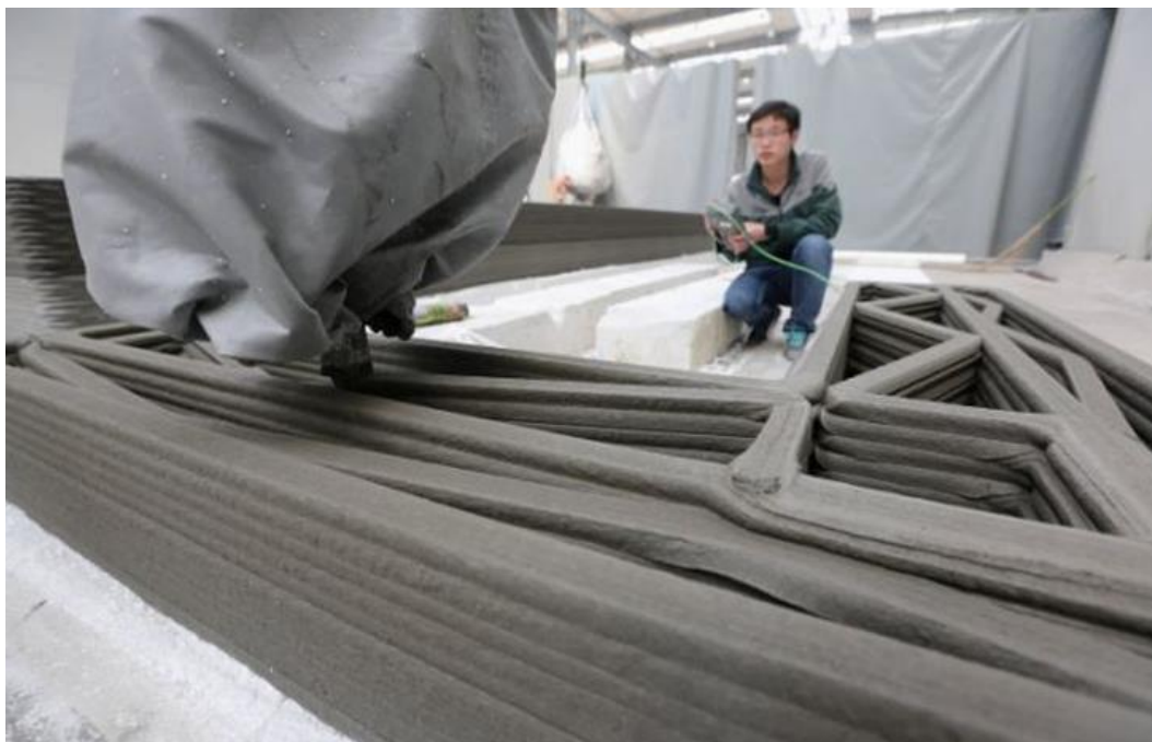
Figura 4.25 – Processo de deposição de betão da empresa WinSun.
