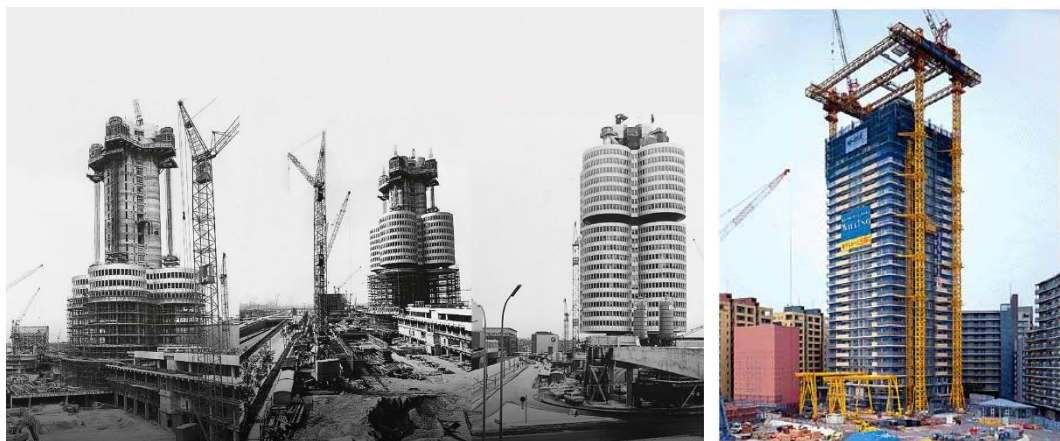
Figura 3.14 – Processos industriais de construção vertical ins-situ. Construção da BMW-Tower em 1972. Após a construção de um núcleo central onde continha os serviços do edifício, o sistema caracterizava-se pela construção dos andares junto ao solo, em torno do núcleo, e elevados, um por um, à medida que fossem sendo construídos (esquerda). Construção do Juroku Bank em 1991. Este método consistia numa plataforma de elevação automática, que subia ao longo da construção do edifício, onde integrava em ambiente de fábrica um conjunto de sistemas automatizados, como soldagem ou montagem de painéis (direita).
