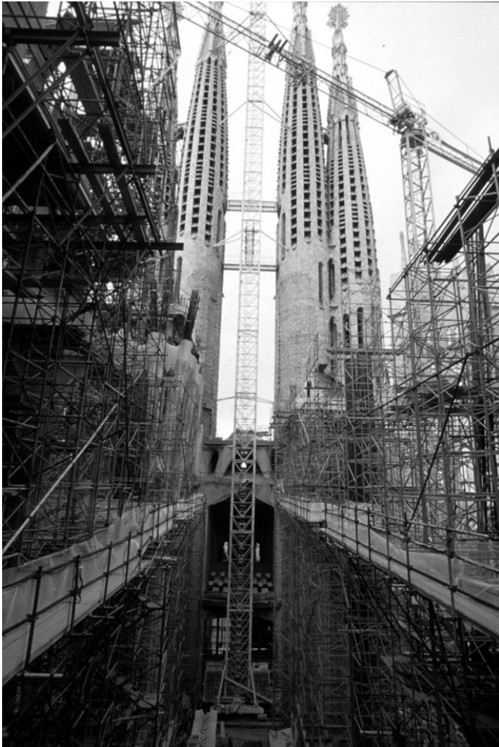
Figura 4.2 – Catedral da Sagrada Família em construção. Vista interior da posição da rosácea na “Fachada de la Paixón”.
