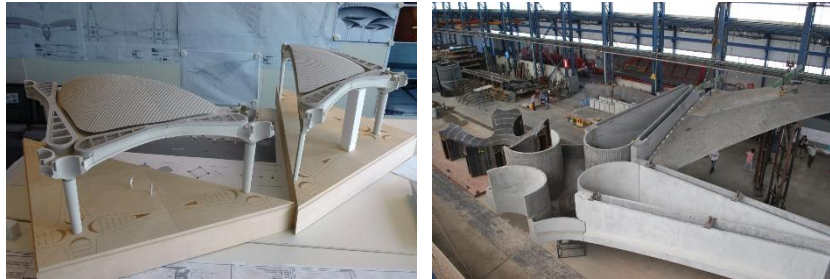
Figura 3.11 - Queen Alia Airport, Foster + Partners. Maquete do modulo da cobertura (esquerda); Elemento da cobertura em construção (direita).
