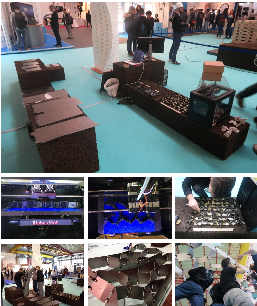
Figura 4.53 – Fabricação e montagem do “Tri-Arch”. Ambiente de trabalho no decorrer da CON-CRETA 2017 (em cima); Fabricação das juntas (segunda linha); montagem da estrutura (terceira linha).
