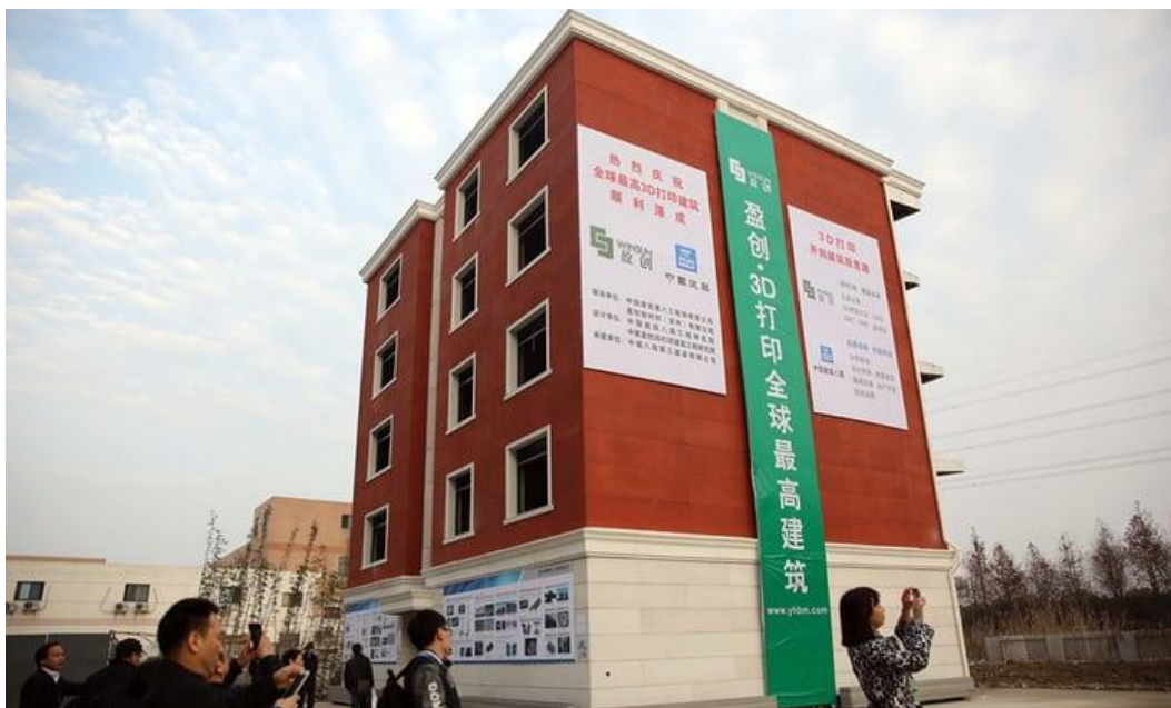
Figura 4.27 – Prédio com cinco andares construído em 2015.
