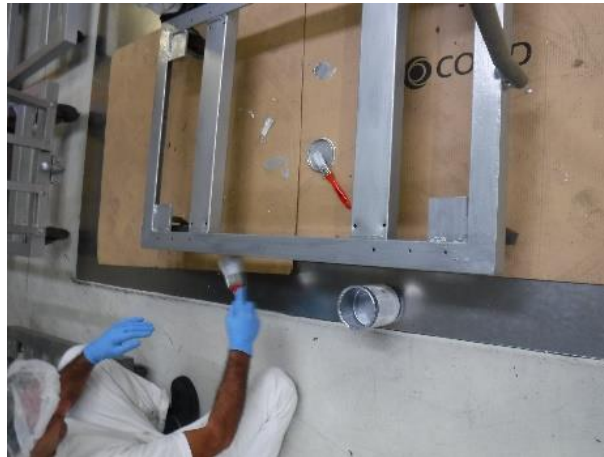
Figura 4.3 - Reestruturação de carrinhos de apoio
