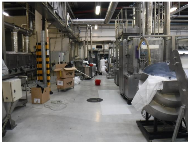
Figura 4.4 - Limpeza da LA1
