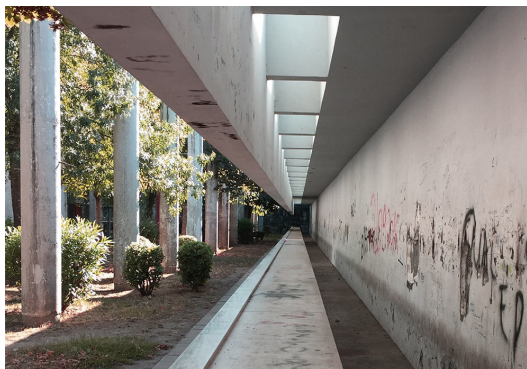
105. Antiga banca do peixe, agora fachada da Escola de Dança – vista do interior para o jardim
