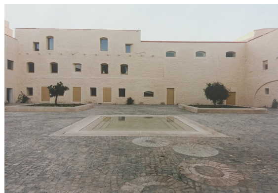
244. Fachada norte do interior do Pátio – espaço do antigo claustro do Convento.
