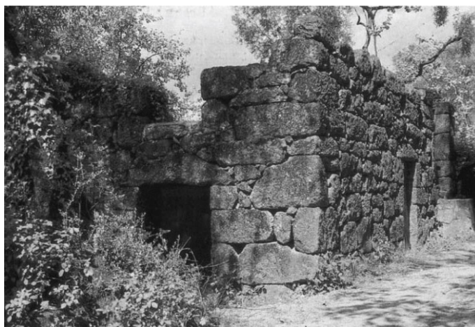
50. Reconversão de uma ruína no Gerês, ruína preexistente, vista da rua.
