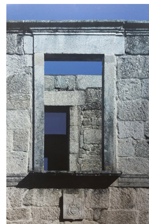
222. Vão do claustro e janela.
