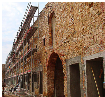
286. Fotografia da obra – pormenor da composição e textura das paredes.
