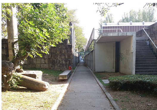
102. Entrada sudoeste – Vista para as escadas de acesso ao percurso superior e pilares tombados.
