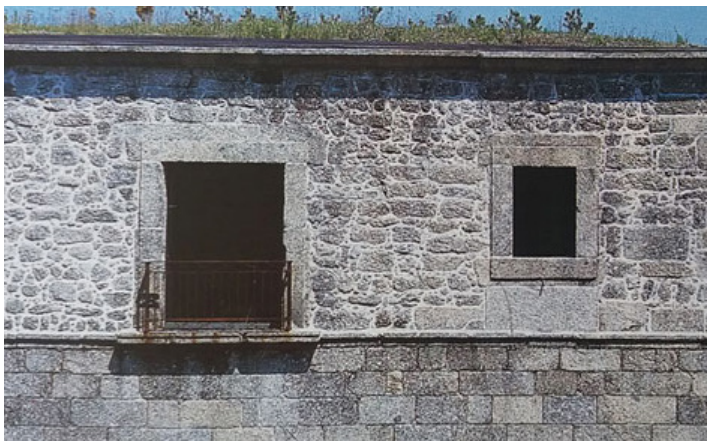
218. As janelas como buracos na parede e tratamento da pedra da fachada.
