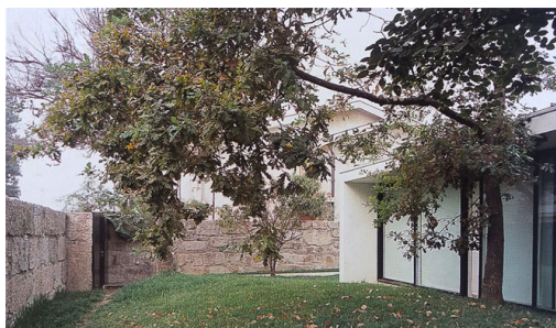
43. Fachada sudeste e muro de limitação do lote – Casa 1 em Nevogilde.
