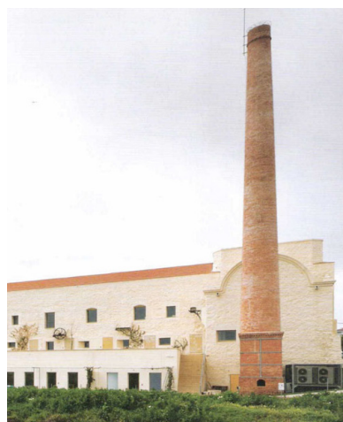
238. Chaminé da antiga Fábrica depois da intervenção.
