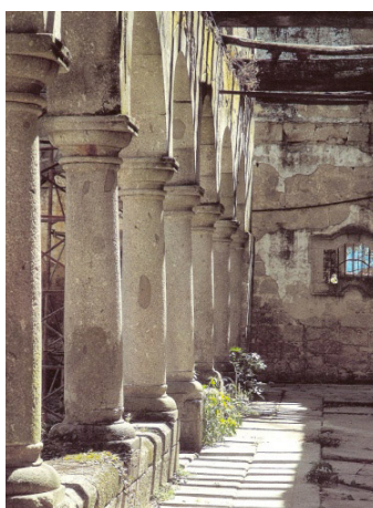
209. Claustro antes da intervenção.
