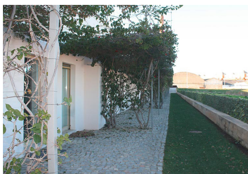
254. Pormenor – a ideia dos contrafortes presente no muro que define as habitações.
