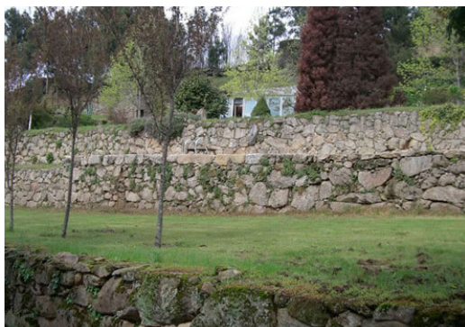
155. O terreno estruturado em socalcos e a dissimulação da obra – Casa em Baião.
