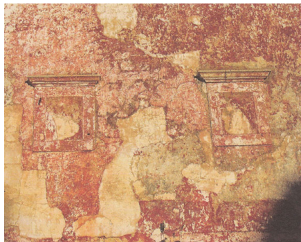
278. Antigas janelas encerradas do Convento.
