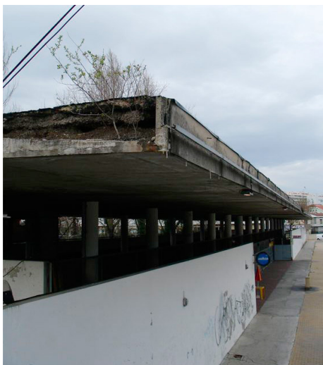
113. Mercado Municipal de Braga, 2008 – Muro longitudinal de betão.
