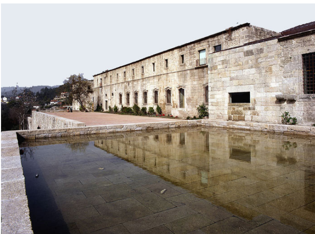
195. Fachada sul – vista para o espelho de água e terraço.
