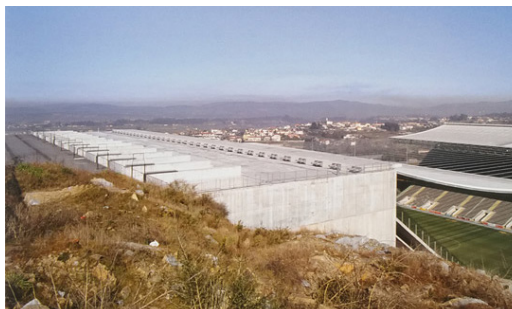
25. Pormenor do encontro entre o estádio e a pedra – Estádio Municipal de Braga.
