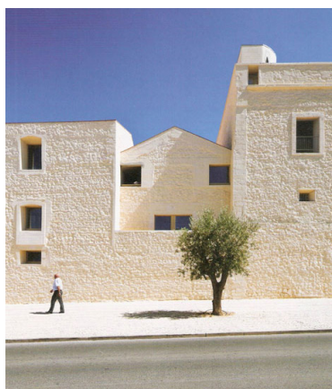
288. Fachada norte – pormenor.
