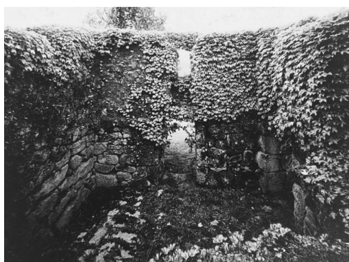
163. A ruína como jardim fechado – Casa em Baião.
