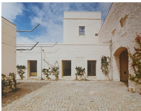
243. Entrada para o Pátio – ala oeste.
