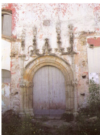
227. Portal manuelino – entrada lateral da Igreja do Convento.
