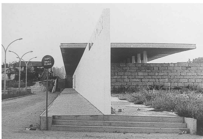
64. Mercado Municipal de Braga – Muro longitudinal de betão e muro do extremo nordeste.
