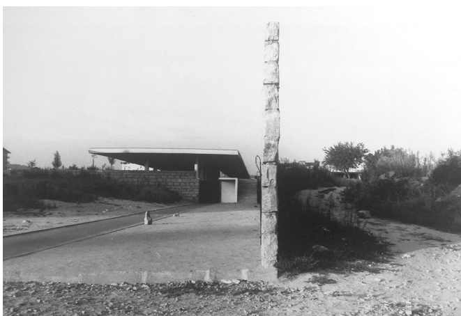
66. Mercado Municipal de Braga – Muro longitudinal de pedra e muro do extremo sudoeste. Vista para uma das entradas e acesso ao percurso exterior a uma cota superior.
