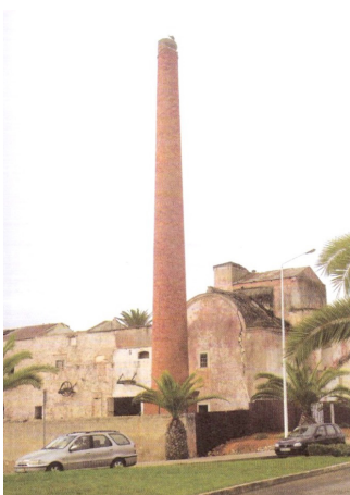
226. Chaminé de tijolo construída pela Fábrica.
