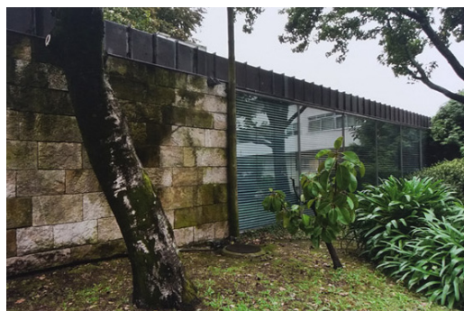
38. Fachada envidraçada da biblioteca – Casa das Artes.
