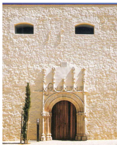
236. Portal manuelino depois da intervenção – entrada para a receção do complexo habitacional.
