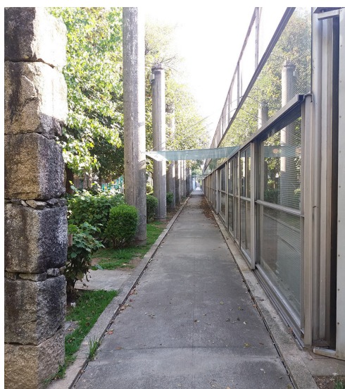
103. Entrada sudoeste – Percurso que atravessa o Mercado Cultural.
