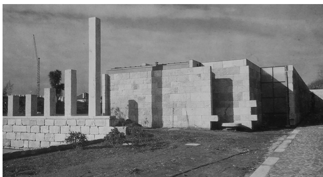
137. Fachada este – plano de pedra cego. Vista para os pilares colocados no muro que separa o jardim e o campo de ténis.
