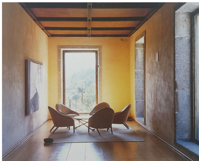
205. Pormenor do corredor dos quartos – o rodapé em aço inox, caixilharia minimalista e caixotões do teto em aço corten.
