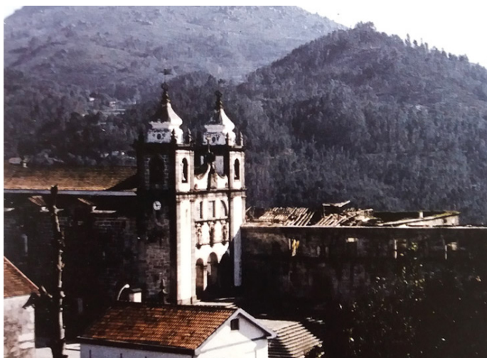
177. A igreja e o antigo Mosteiro arruinado – vista norte.
