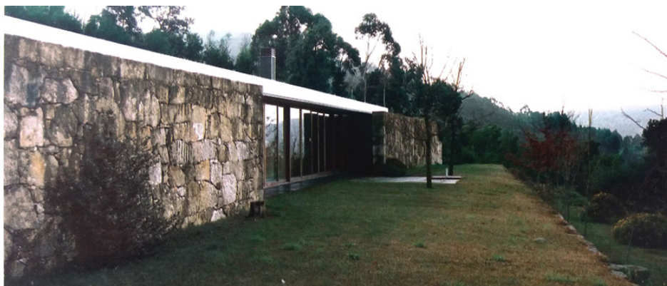
165. Alçado principal: a casa como um socalco – Casa em Moledo.
