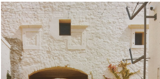
289. Entrada na Ala oeste – Pormenor vãos.
