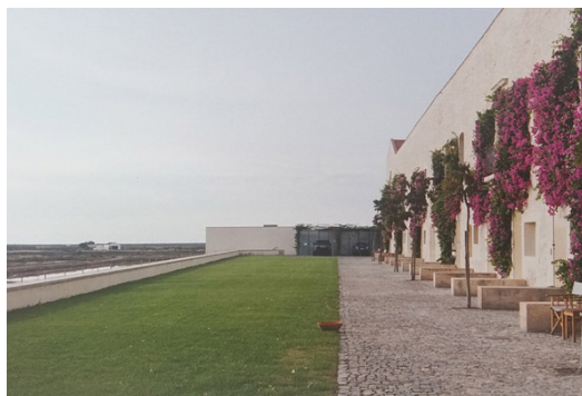
250. A cobertura do Corpo das Salinas. Vista ala este.
