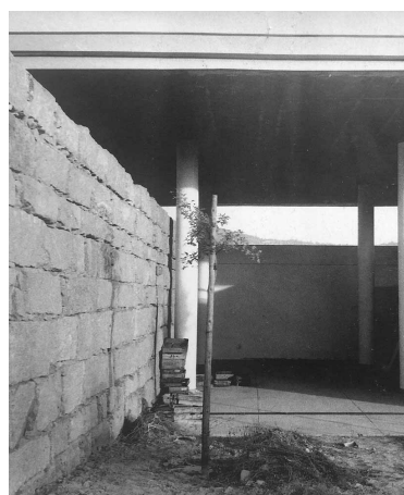
65. Muro extremo sudoeste.
