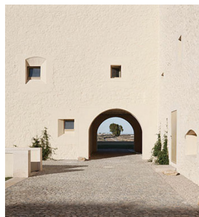
276. Arco construído à semelhança do preexistente na ala este.
