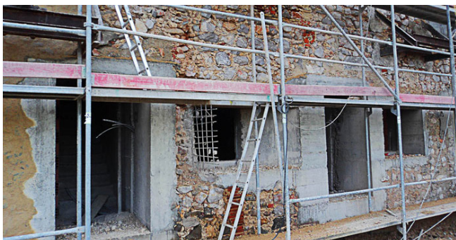
285. Fotografia da obra – a abertura dos novos vãos.
