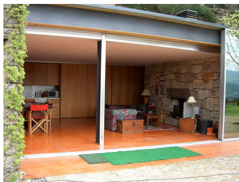
160. Interior – a parede construída com as pedras retiradas do muro de suporte – Casa em Baião.
