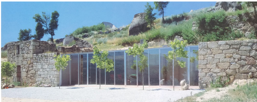
154. A casa inserida no socalco – Casa em Baião.
