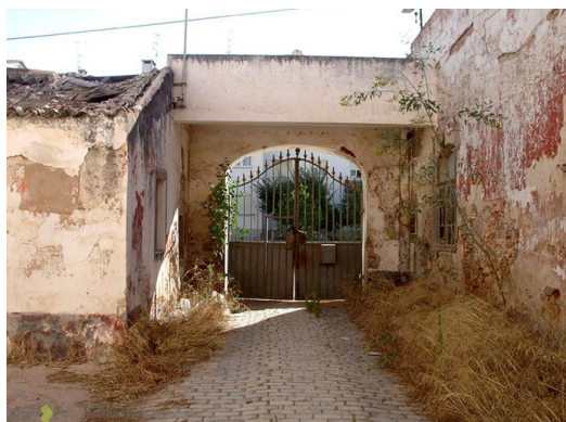
239. Portão de entrada no conjunto, construção a oeste antes da intervenção.
