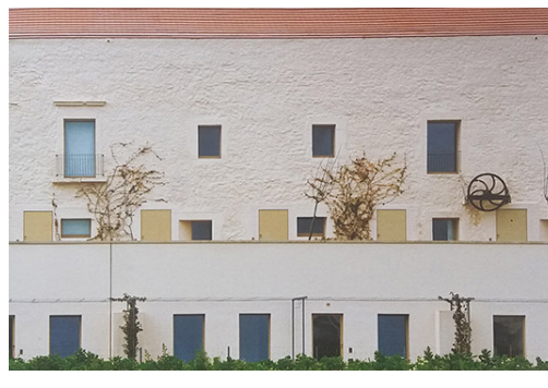
255. Pormenor da fachada este.
