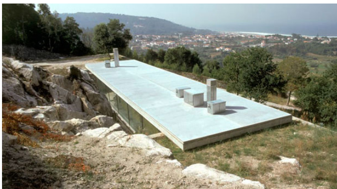
168. 168. | 169. A cobertura e relação com o preexistente – Casa em Moledo.
