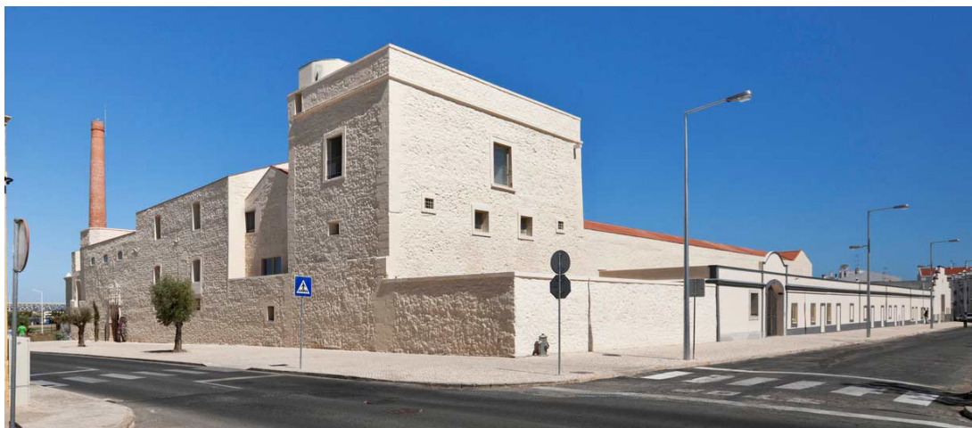
241. Fachadas norte e oeste do complexo habitacional.
