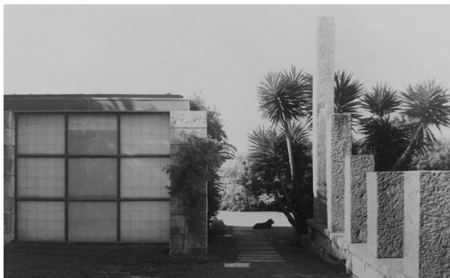
142. Pilares de alturas variadas e acesso exterior ao jardim.
