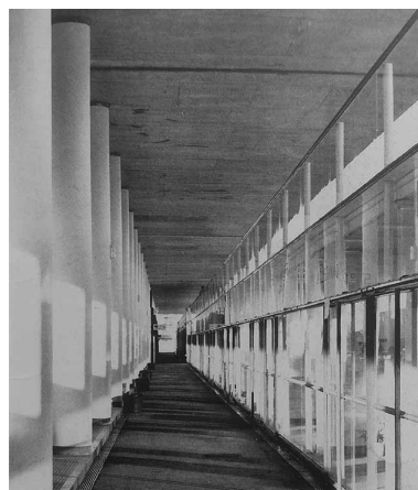
71. Percurso interior do Mercado à cota térrea. Vista para as lojas.
