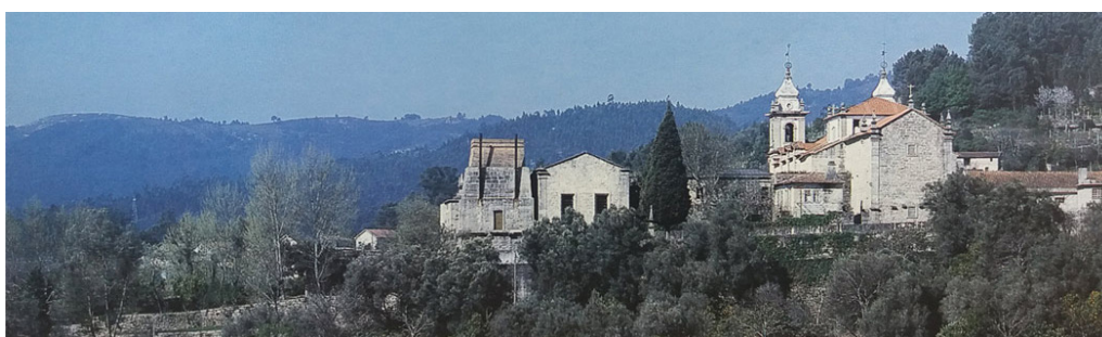
190. Fachada oeste – Reconversão do Mosteiro de Santa Maria do Bouro.
