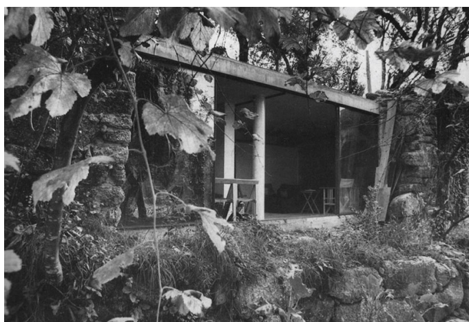
51. Reconversão de uma ruína no Gerês, vista do exterior.
