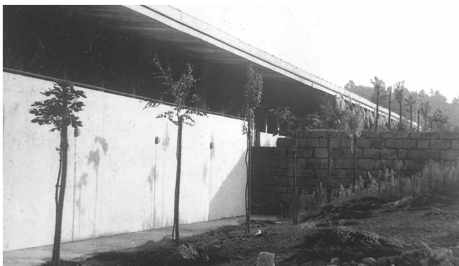
74. Vista exterior do Mercado Municipal de Braga – Muro central e a dissociação da cobertura e os planos verticais.
