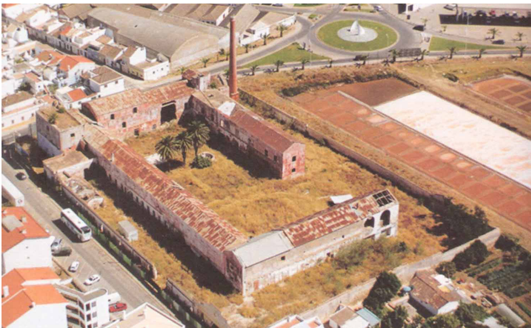
225. Vista aérea do conjunto.
