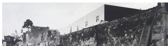
4. Vista dos muros preexistentes – Bairro de São Victor, Álvaro Siza.
