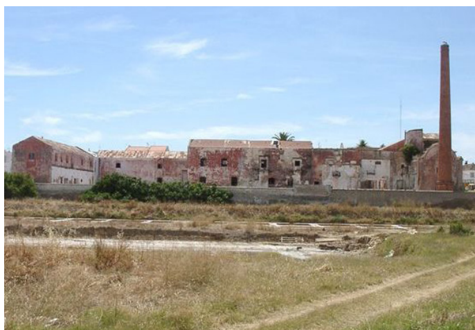
237. Fachada este antes da intervenção.
