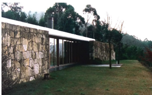
30. A inserção da obra no terreno – Casa em Moledo.
