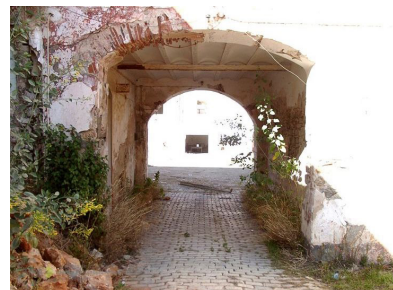
272. Arco preexistente na ala oeste – antes da intervenção.
