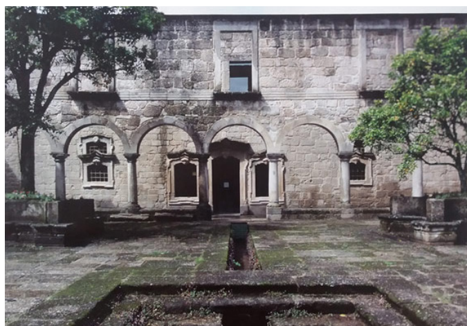
212. Vista este do pátio do claustro.
