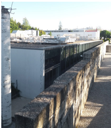
114. Escola de Música – muro longitudinal de betão recuperado em pedra.
