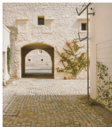
274. Arco preexistente na ala oeste depois da intervenção – entrada para o Pátio.
