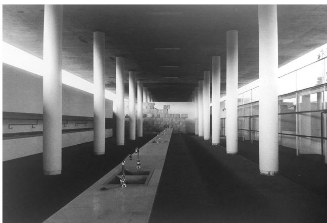
62. Sucessão de pilares. Interior do Mercado Municipal de Braga, zona de comércio diário. Vista para o muro central fragmentado.
