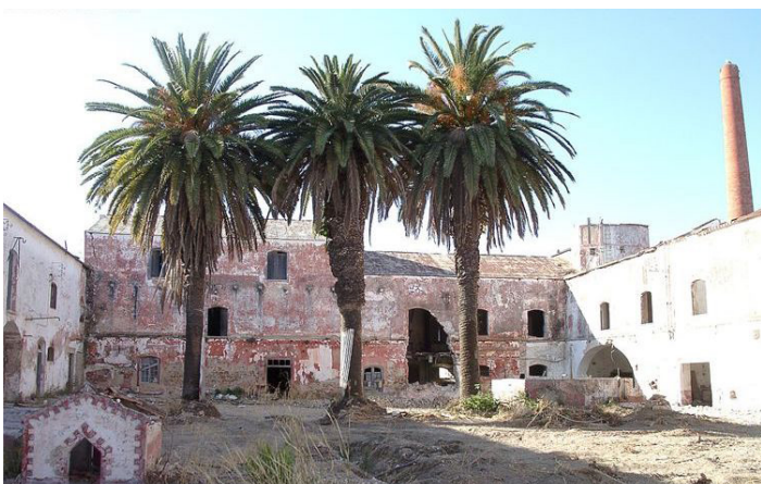
229. Fachada sul da Igreja – vista para a zona onde se localizava o antigo claustro do Convento.
