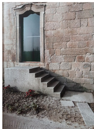
201. Escadas de granito de acesso ao terraço.
