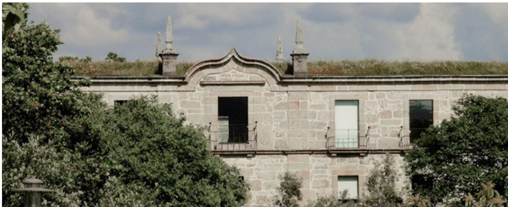
217. Fachada este – pormenor da cobertura vegetal.
