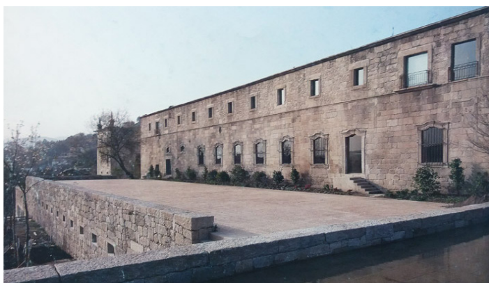
213. Fachada sul – vista para o terraço e fachada do novo corpo de serviços.
