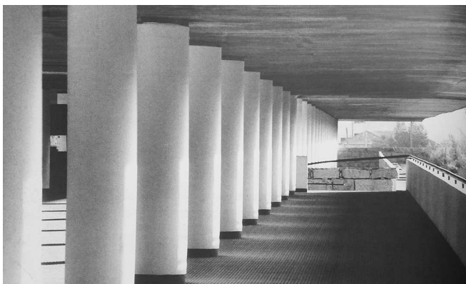
80. Piso superior do Mercado Municipal de Braga. A cobertura sustentada pelos pilares.
