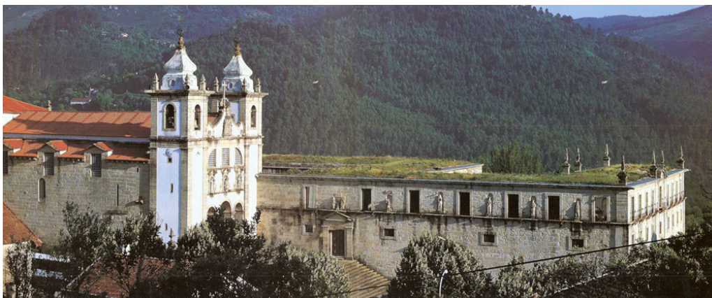
191. Vista norte – a aparência de edifício abandonado.
