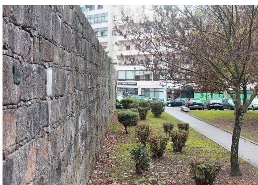
111. Entrada sudoeste – Muro longitudinal de pedra.
