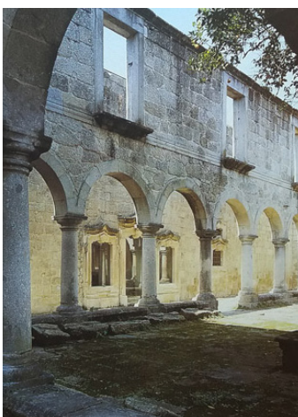
211. As pedras dispostas no chão do pátio do claustro.
