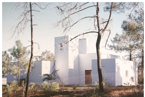
42. Fachada norte e oeste – Casa em Tavira.
